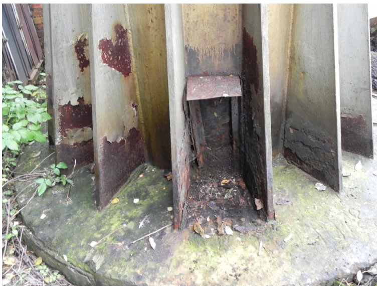
Fot.2 Fragment podstawy i żebra wzmacniające komina Widoczna skorodowana wyczystka kominowa
