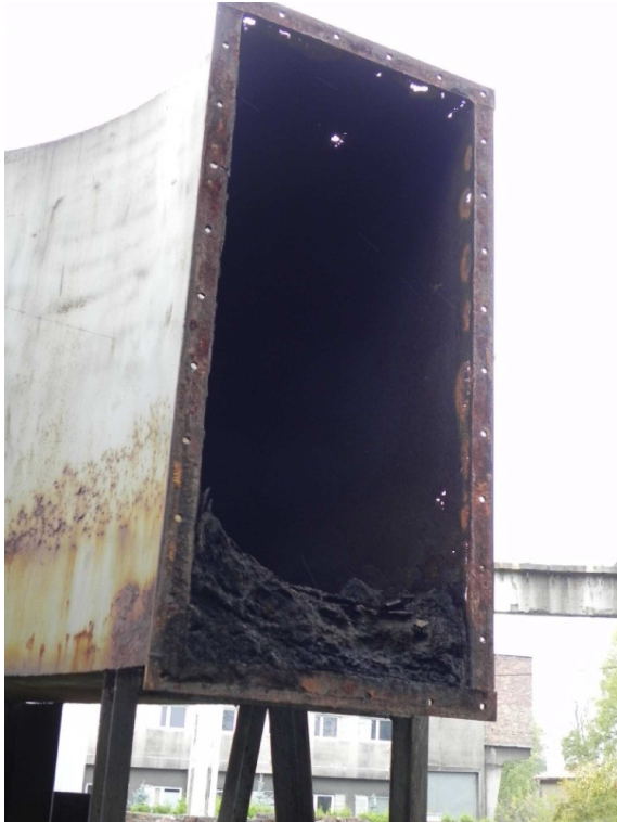
Fot.8. Fragment czopucha (widoczna korozja wżerowa)
