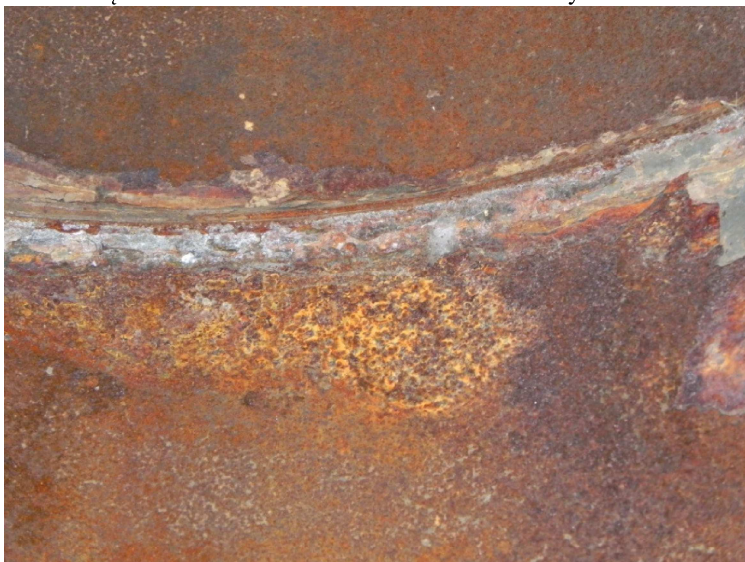
Fot.6. Fragment wewnętrznej powierzchni trzonu komina w rejonie połączenia dwóch trzonów
