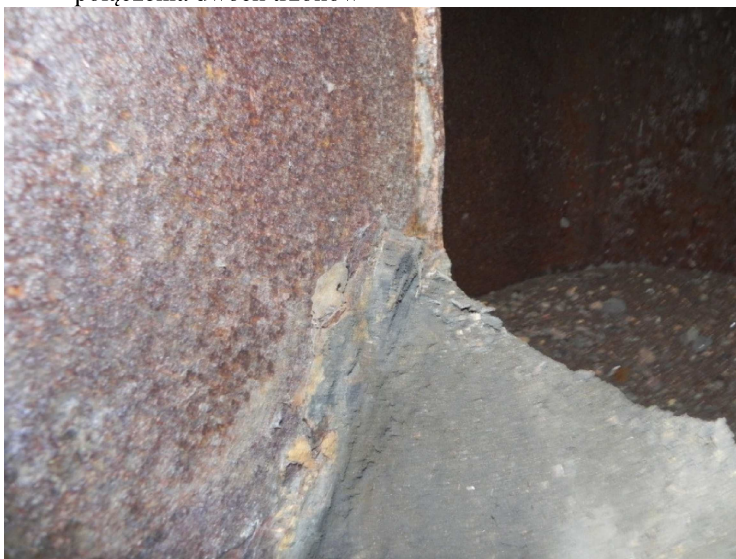
Fot.7. Połączenie czopucha z trzonem komina (załączający popiół i rdza na wysokość pierwszego członu)
