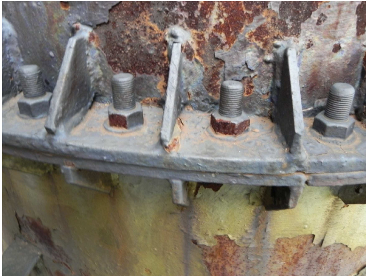
Fot.5. Połączenie śrubowe dwóch trzonów kominowych
