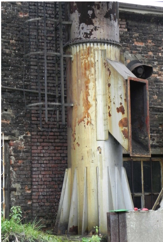
Fot.9. Fragment pierwszego członu z drabiną wejściową (widoczna korozja powierzchniowa)
