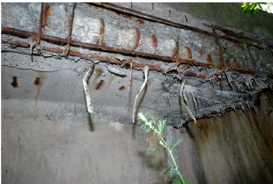
Fot.6.2 – Szczegół krawędzi płyty pomostu w miejscu destrukcji gzymsu (rejon podpory 1)
