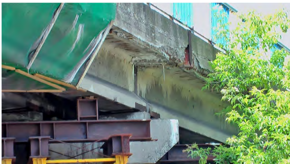
Fot.6.6 – Uszkodzenia gzymsu i spodu płyty pomostu na styku przęsła 1 i 2 – nad jezdnią w kierunku Cieszyna.
