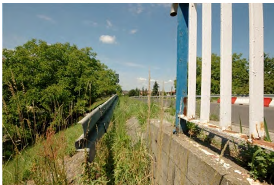
Fot.9.12 – Uszkodzona bariera drogowa na dojeździe od strony Wojkowic – bariera od strony południowej (widok 3).
