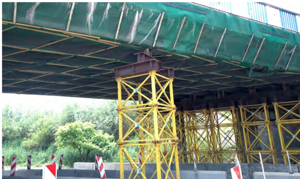
Fot.8.2 – Podparcie tymczasowe uszkodzonej belki skrajnej
