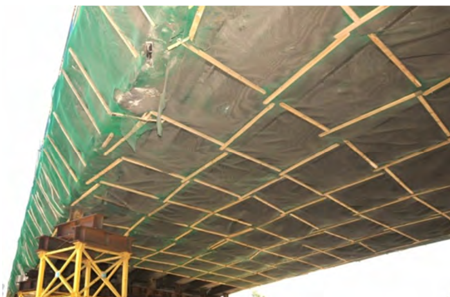
Fot.9.9 – Uszkodzone zabezpieczenie z siatki tworzywowej. Siatka zabezpiecza użytkowników ruchu przed odpadającymi elementami betonu (otuliny).
