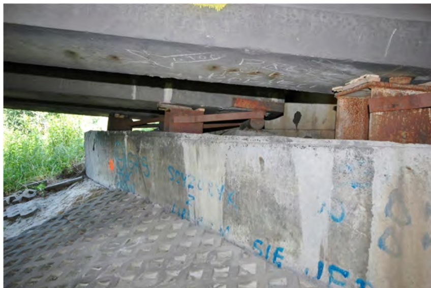
Fot 3.11 – Przyczółek (podpora 5). Braki elementów ażurowych umocnienia stożka. Uszkodzenia ciosów, konstrukcja podparta tymczasowo na stołkach stalowych).
