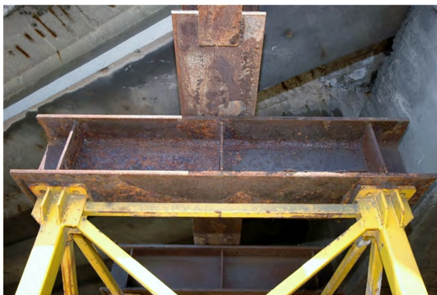
Fot.4.20 – Klatka podpierająca przęsło w obrębie podpory 4
