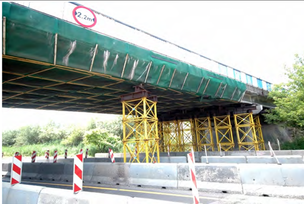
Fot.8.1 – Podparcie tymczasowe przęsła 2 w obrębie podpory 2 wraz z dodatkową podporą uszkodzonej belki skrajnej (podpora na jezdni w kierunku Cieszyna).
