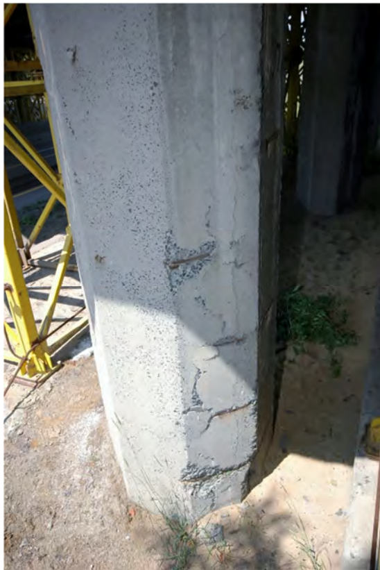
Fot.4.21 – Rysy i odspojenia betonu wraz z korozją strzmiom słupa skrajnego podpory 4
