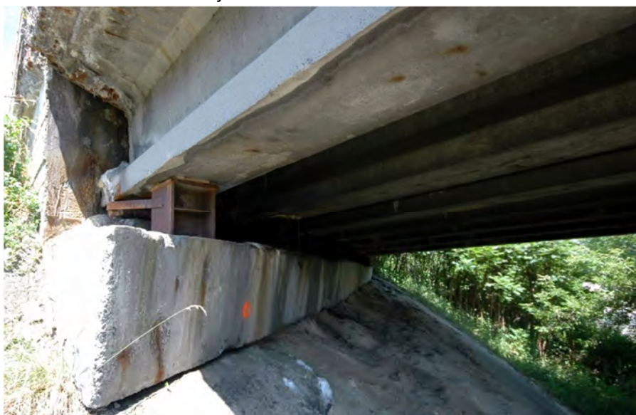
Fot.3.2 – Przyczółek (podpora 1). Braki płyt betonowych umocnień stożka. Widoczne odsłonięte skorodowane zbrojenie belki skrajnej . Podparcie tymczasowe belek na stołkach stalowych.
