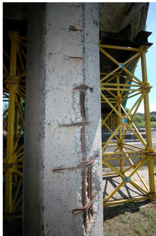
Fot.4.4 – Słup skrajny podpory 2. Brak otuliny i uszkodzone strzemiona.
