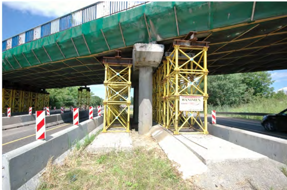
Fot.4.8 – Widok na podpórę 3. Widoczne umocnienia podpór pośrednich oraz zabezpieczenie siatkowe przęseł 2 i 3.
