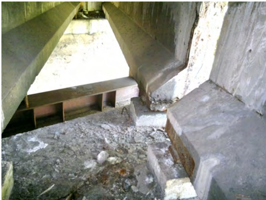
Fot.6.4 – Zawilgocenia na powierzchni górnej oczepu i powierzchniach bocznych dźwigarów. Korozja elementów stalowych w tym spłotów sprężających.
