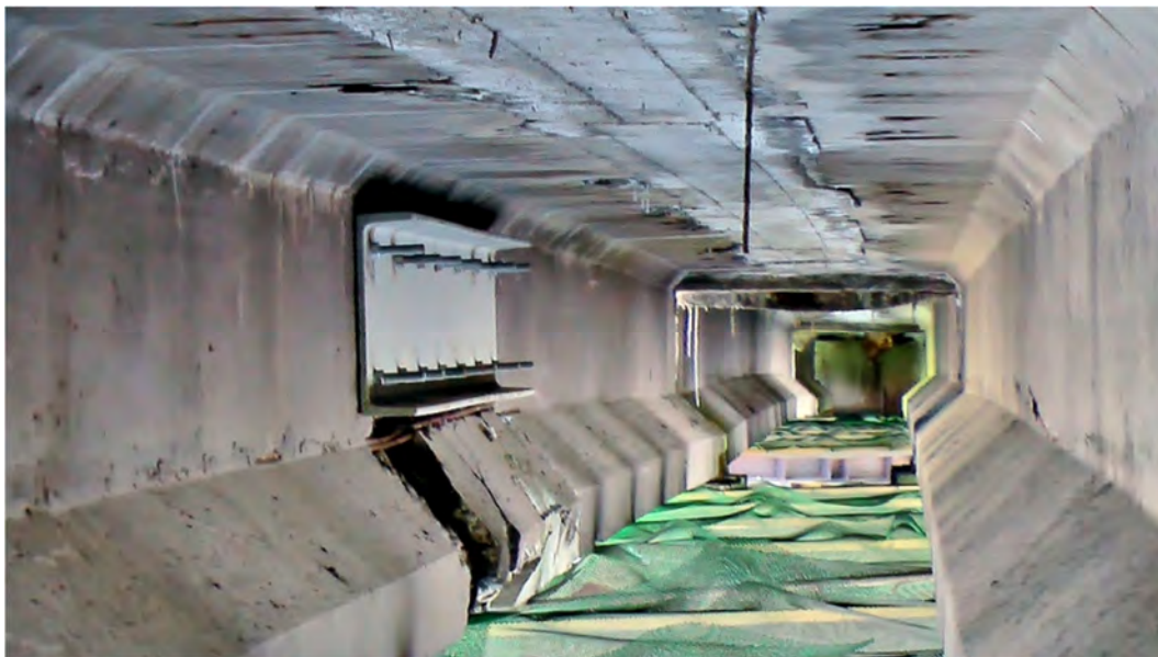
Fot.7.1 – Zabezpieczenie uszkodzonego dźwigara głównego w miejscu zerwania splotów sprężenia nakładką z ceownika. Widok od strony przęsła 1
