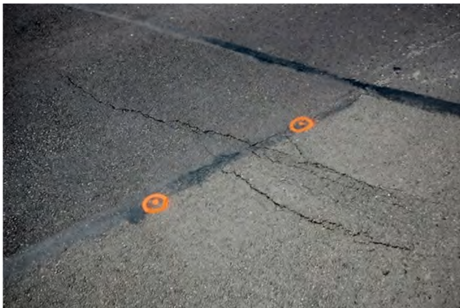
Fot.2.4 - Pęknięcia poprzeczne nawierzchni w rejonie dylatacji nad przyczółkiem. Lokalizacja reperów pomiarowych. (Przyczółek 5 – strona północna)
