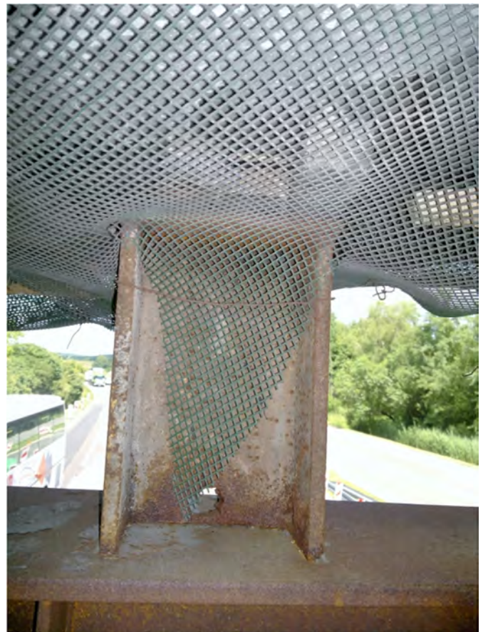
Fot.7.6 – Podparcie tymczasowe w miejscu uszkodzenia – stółek stalowy z podklinowaniem
