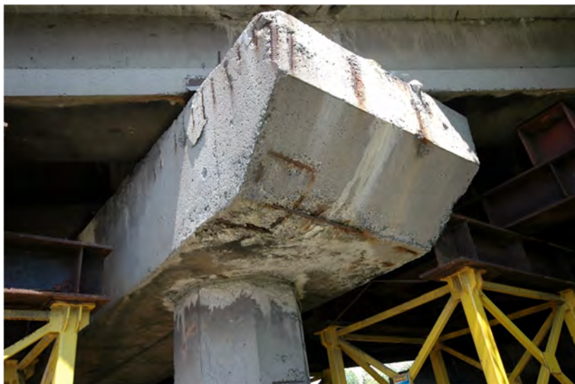
Fot.4.17 – Zawilgocenie na spodzie oczepu podpory 4. Wykwity i korozja stali zbrojeniowej.
