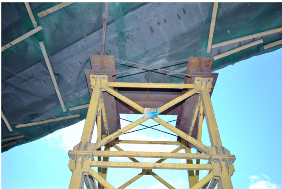
Fot.5.4 – Uszkodzona belka skrajna wraz z podparciem (widok od spodu konstrukcji).
