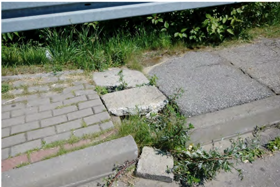
Fot.2.10 - Uszkodzenia chodnika i odpływu wody na dojściu do obiektu. (Przyczółek 1 – strona północna)
