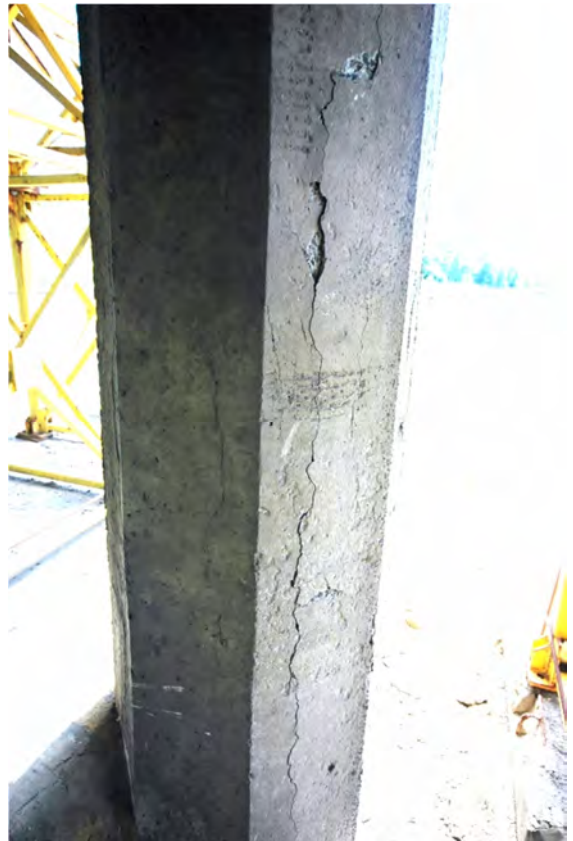
Fot.4.14 – Słup skrajny podpory 3. Zarysowanie o charakterze przeciążeniowym i odspojenia betonu.
