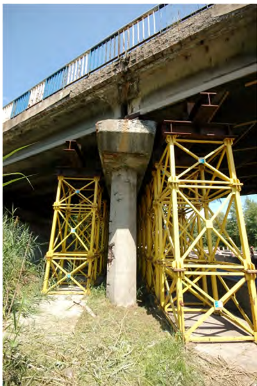
Fot.4.1 – Widok na podporę 2. Widoczne uszkodzenia gzymsu, belek skrajnych i filara.
