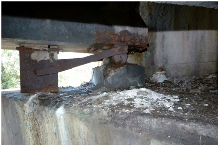
Fot.3.6 – Podparcie belki skrajnej na przyczółku 1. Skorodowane łożysko wałkowe. Spękany cios podłożyskowy. Widoczne wykwyty i zacieki z nieszczelnej izolacji i spękanej dylatacji.
