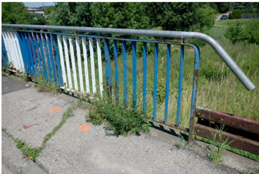
Fot.2.5 - Zdeformowany chodnik. Korozja elementów balustrad i pasa profilowego bariery drogowej. Wegetacja roślinności w pęknięciach nawierzchni. (Przyczółek 5 – strona północna)
