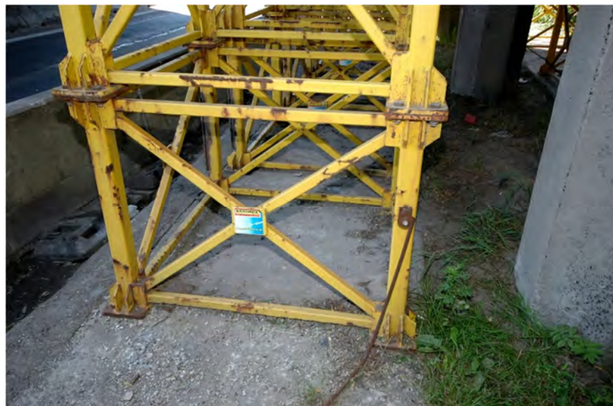
Fot.4.6 –Klatki podparcia tymczasowego od strony jezdni. (Podpora 2)
