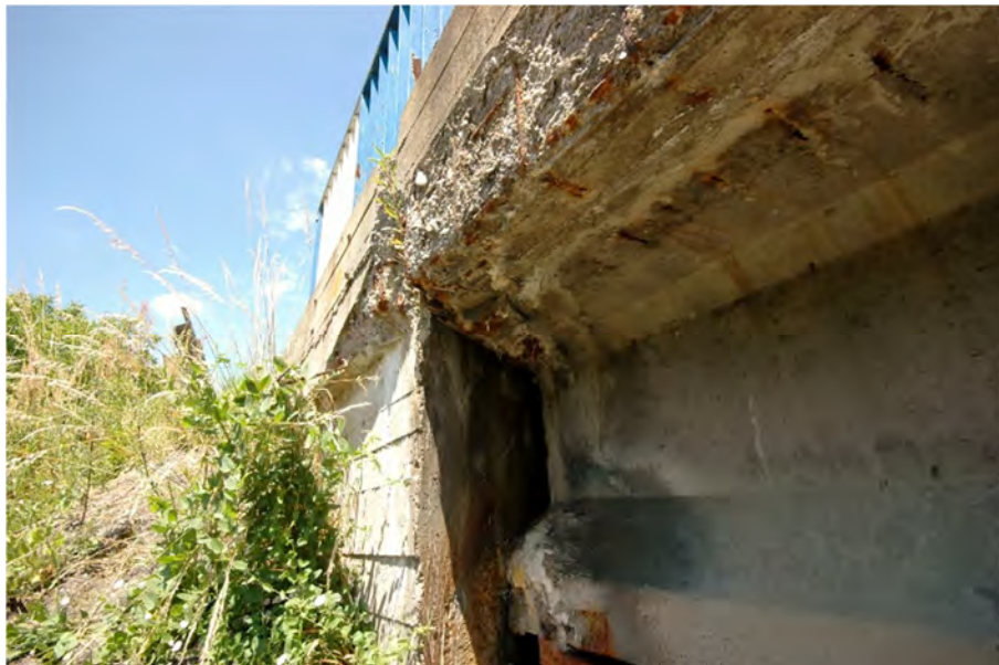
Fot.3.5 – Uszkodzenie gzymsu i zawilgocenie ściany zapleczonej przyczółka. Wegetacja roślinności na skarpie. (Podpora 1)
