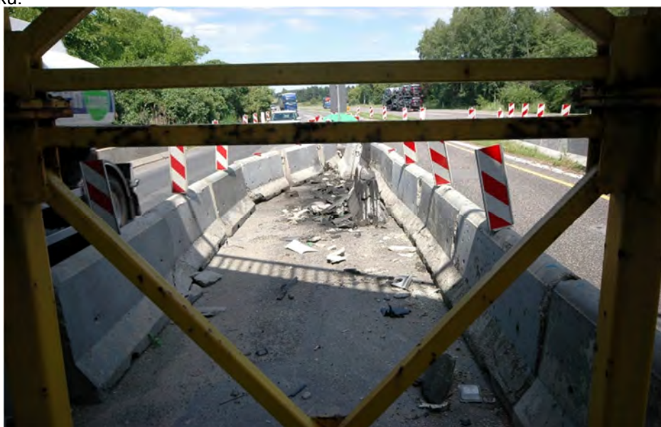
Fot.9.6 – Widok na klin rozdziału pasów ruchu od strony podpory tymczasowej podpierającej uszkodzoną belkę – podpora na jezdni w kier. Cieszyńska.
