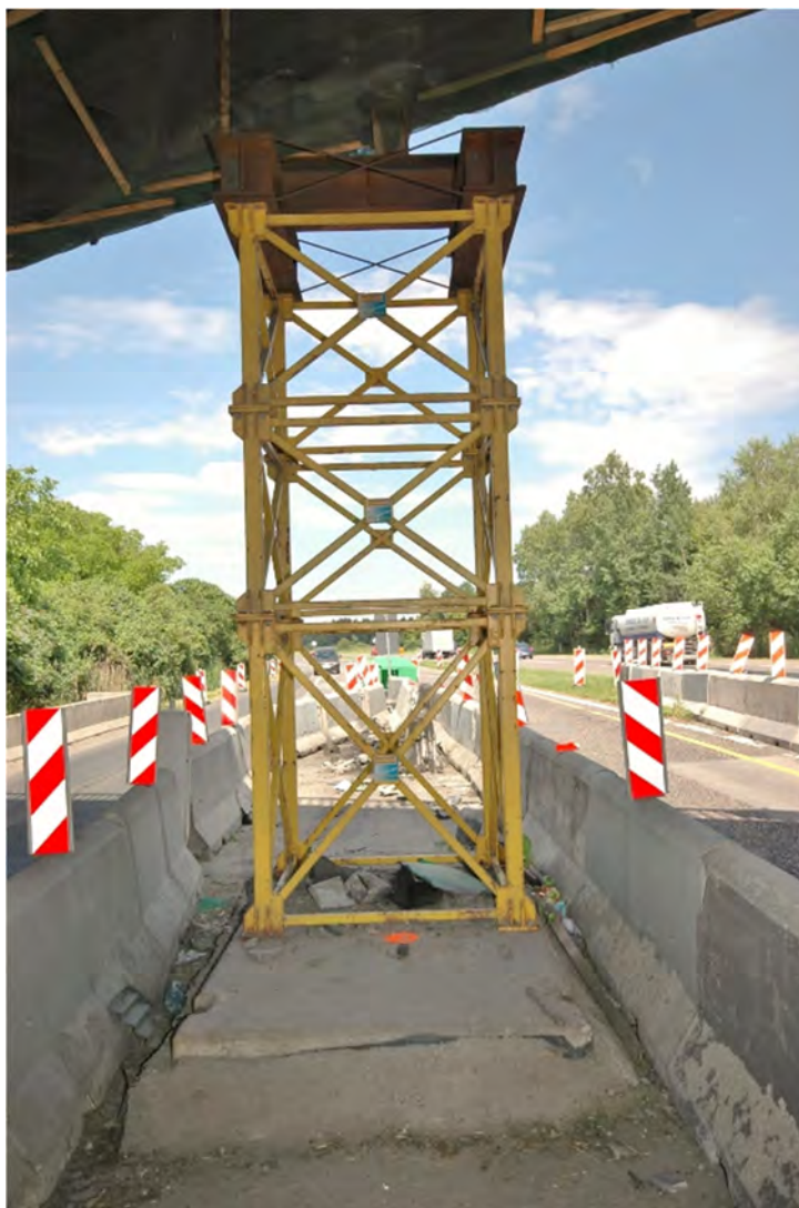
Fot.5.1 – Podparcie uszkodzonej belki skrajnej przęsła 2 na jezdni w kier. Cieszyna (Podpora tymczasowa)
