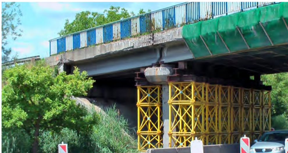
Fot.8.3 – Podparcie tymczasowe przęsła 1 i 2 w rejonie podpory 2 (widok od strony południowej)
