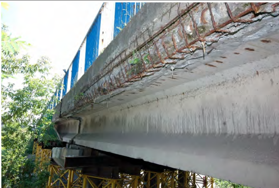
Fot.6.1 – Belka skrajna z odsłoniętym i skorodowanym zbrojeniem gzymsu.
