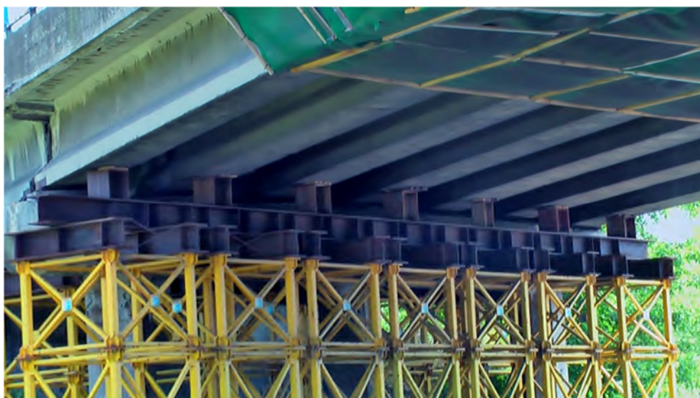
Fot.8.9 – Podparcie tymczasowe przęśła 3 i 4 w rejonie podpory 4 (widok od strony pasa rozdziału)
