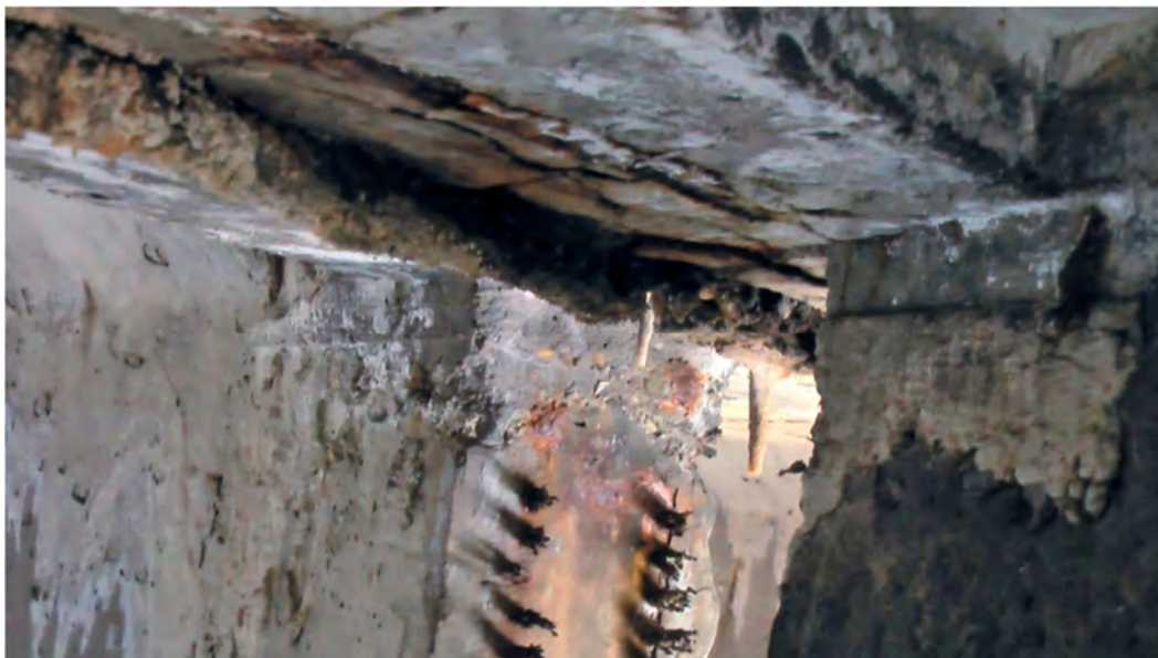
Fot.6.7 – Uszkodzenia czoła dźwigarów. Widoczne powierzchniowe uszkodzenia betonu oraz korozję splotów.
