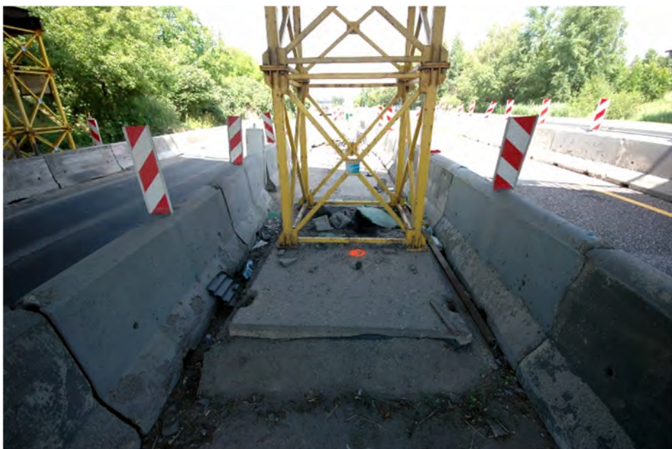
Fot.5.5 – Podpora klatki podpierającej uszkodzoną belkę.
