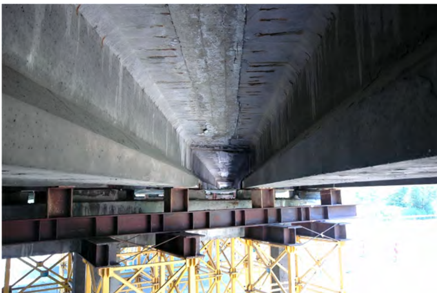
Fot.6.3 – Styk belek, widoczna korozja zbrojenia oraz zacieki na spodzie półek górnych dźwigarów głównych spowodowana nieszczelnościami izolacji pomostu
