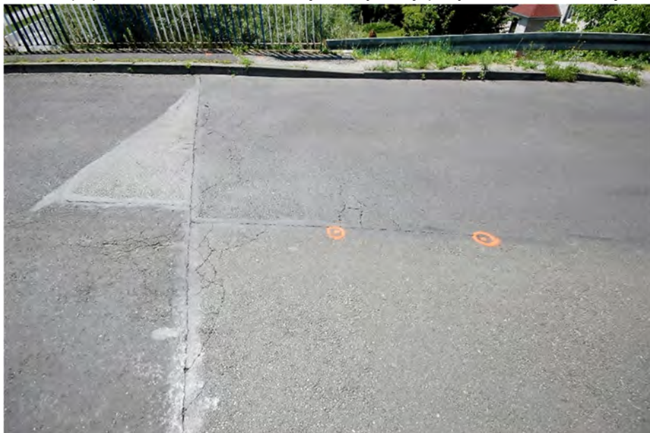
Fot.2.9 - Zdeformowany chodnik. Wegetacja roślinności. Spękania nawierzchni w obrębie dylatacji przyczółka Uszkodzenie bariery drogowej od strony Wojkovic. (Przyczółek 1 – strona południowa)
