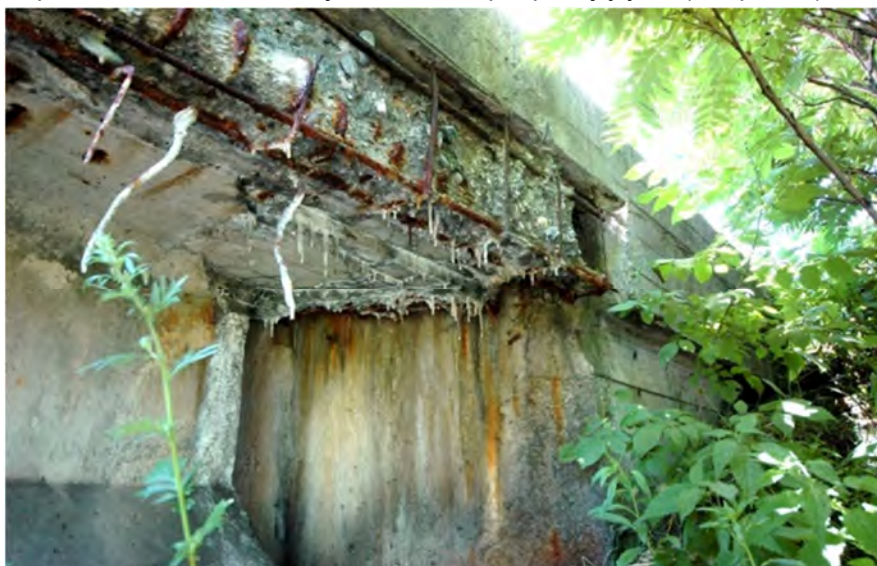
Fot 3.9 – Uszkodzenie gzymsu nad przyczółkiem 1 – widoczne odsłonięte i skorodowane zbrojenie, Mocne zawilgocenie powierzchni ściany zapleczej przyczółka i belki skrajnej. (Podpora 1).
