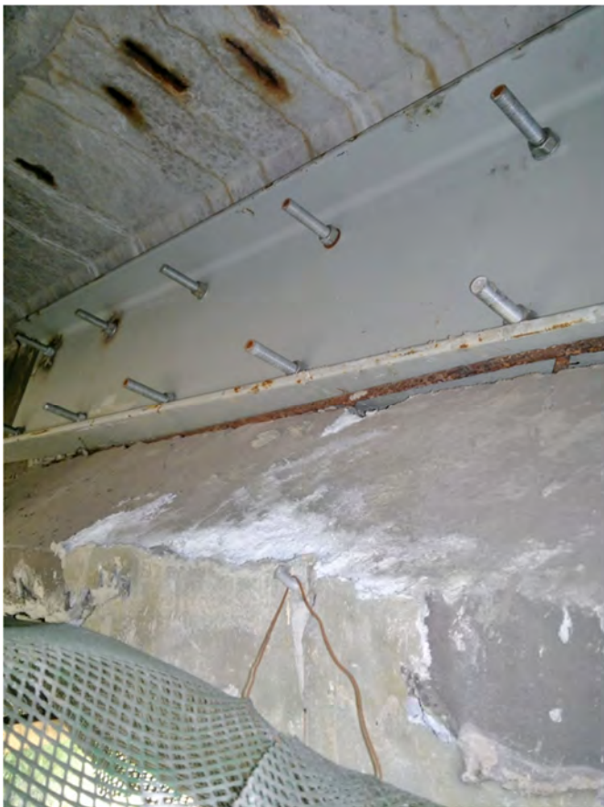
Fot.7.5 – Usztywnienie nakładkami w miejscu uszkodzenia i zastosowania nakładek – widok 3
