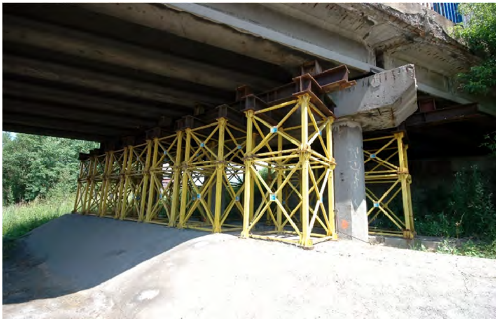
Fot.8.7 – Podparcie tymczasowe przęśła 3 i 4 w rejonie podpory 4 (widok 1 od strony południowej)
