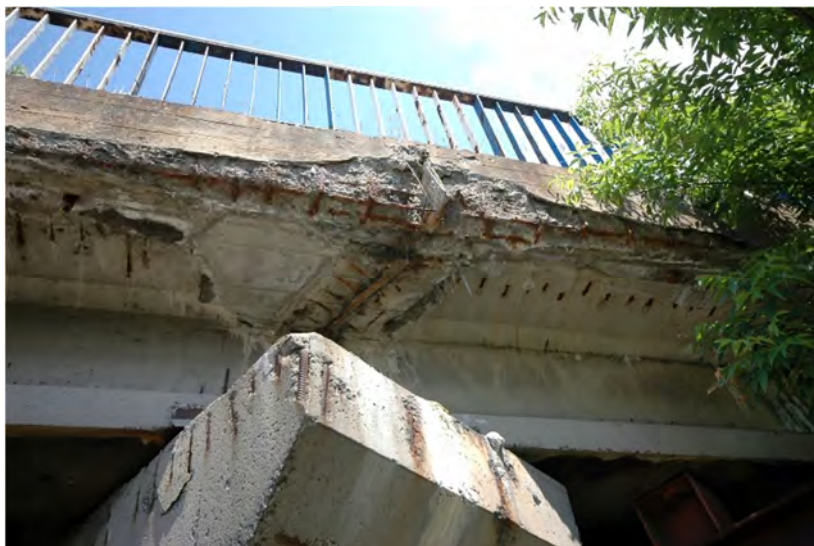
Fot.4.16 – Uszkodzenia gzymsu oraz spodu konstrukcji na styku przęseł 3 i 4. Widoczna korozja stali zbrojeniowej, ubytki betonu spodu płyty pomostu. Nieszczelności na styku przęseł
