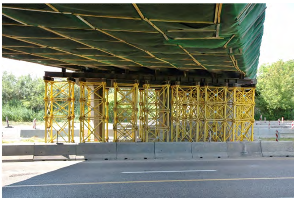
Fot.8.6 – Podparcie tymczasowe przęsła 2 i 3 w rejonie podpory 3 w pasie rozdziału jezdni (widok 2 od strony pobocza jezdni w kierunku Siewierza)
