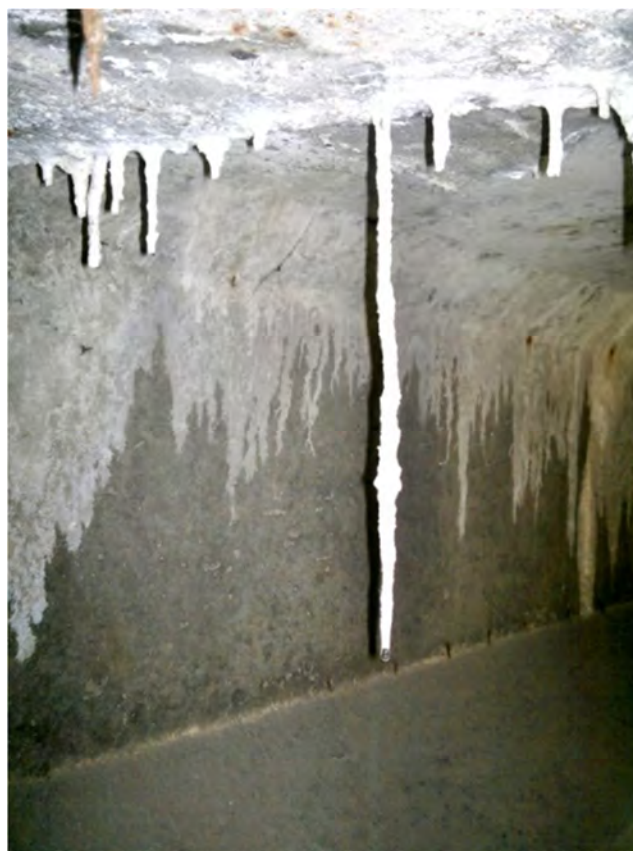
Fot.6.13 – Zacieki, wykwyty i nawisy solne na dźwigarze głównym
