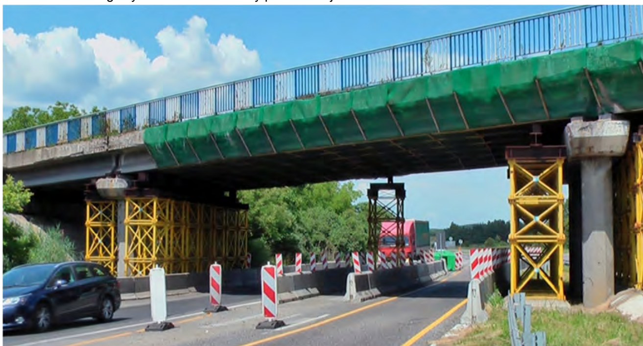
Fot.1.2 - Tymczasowe podparcie na kłatkach rusztowaniowych w przęśle 2.
