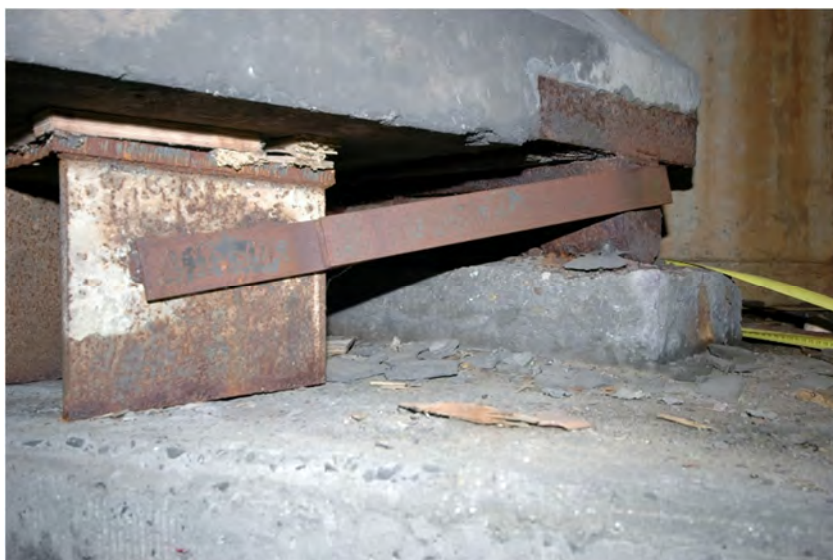
Fot 3.17 – Stółek podparcia tymczasowego. Korozja elementów stalowych, uszkodzenia ciosów podłożyskowych, zacieki na wskutek nieszczelności na ścianie zapleczej. Przyczółek (podpora 5).
