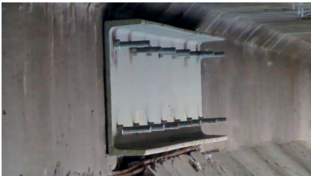
Fot.7.2 – Widok na nakładkę i zestaw 14 śrub połączeniowych (nakładki obustronne)
