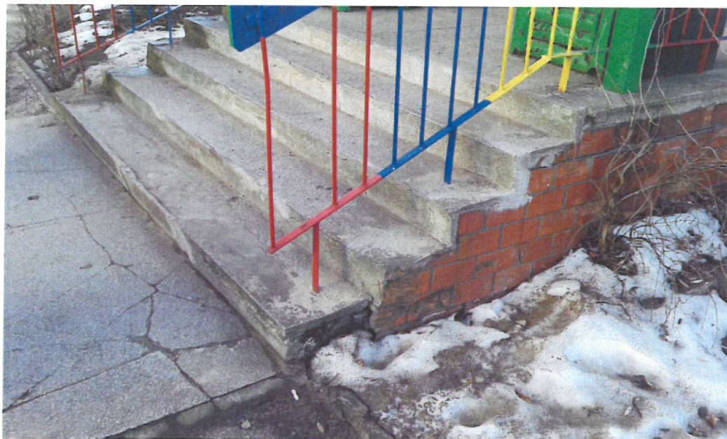
Zdjęcie nr5 : S1 -wejście główne, zadaszone- uszkodzenia cokołu i stopni schodów
