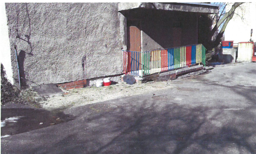
Zdjęcie nr8 : S2 -wejście boczne, zadaszone- uszkodzenia cokołu podestu oraz cokołu budynku P2- plac gospodarczy
