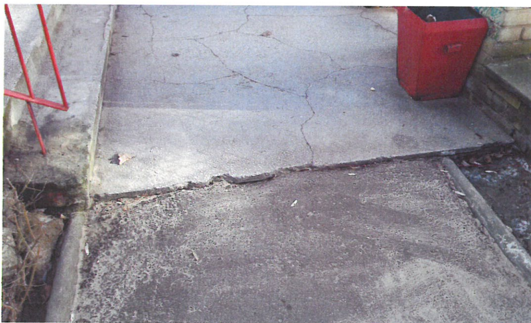
Zdjęcie nr6 : S1 -wejście główne, zadaszone- rysy w płycie z lastrica przed schodami
