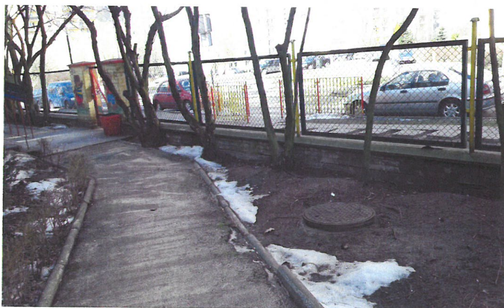
Zdjęcie nr26: D12 - studzienka kanalizacji deszczowej Ch - chodniki
