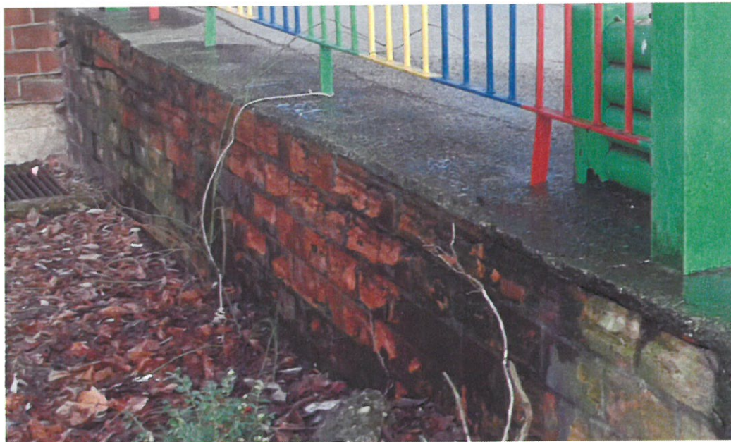
Zdjęcie nr3 : S1 - wejście główne, zadaszone- uszkodzony cokół, widoczne zacieki oraz rysy w posadzce z lastrico St - studzienka okienna
