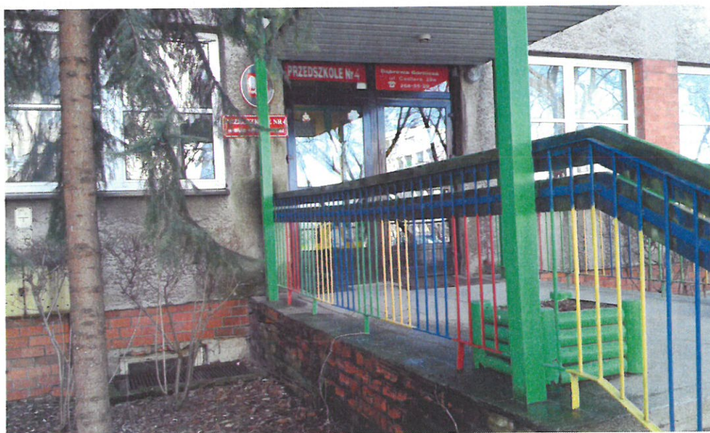
Zdjęcie nr2 : S1 - wejście główne, zadaszone- uszkodzony cokół, widoczne zacieki z zadaszenia bez rynny
