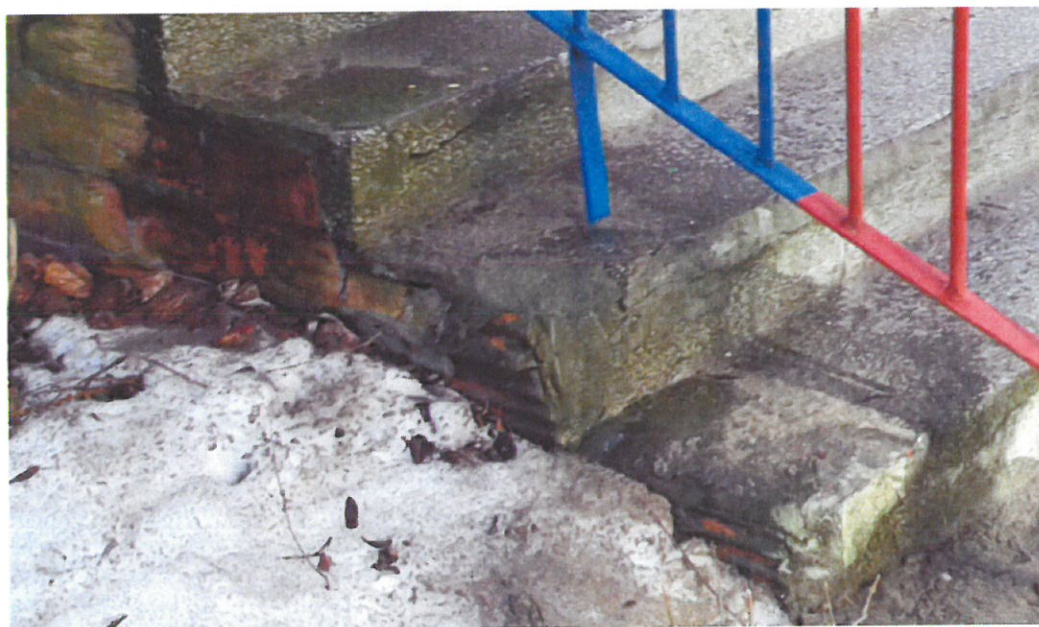
Zdjęcie nr4 : S1 - wejście główne, zadaszone- uszkodzenia cokołu i stopni schodów
