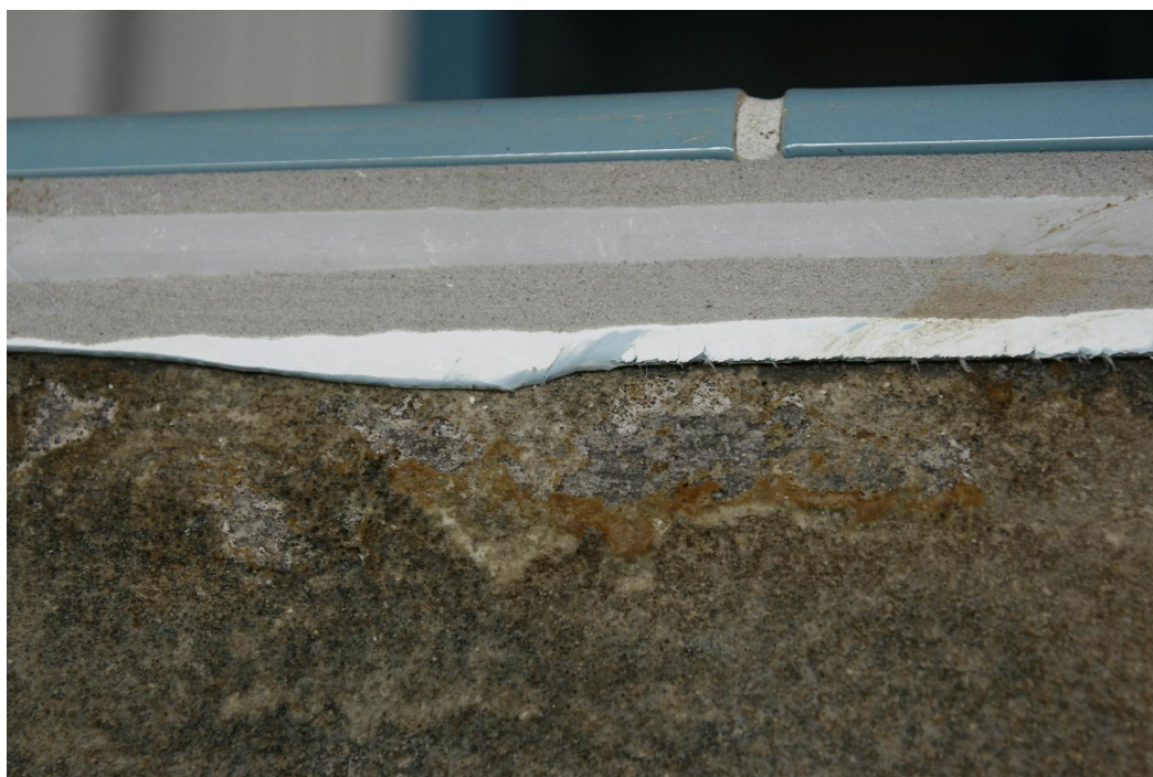
Foto 8 Pozostałości membrany basenowej pod płytkami krawężniowymi basenu
