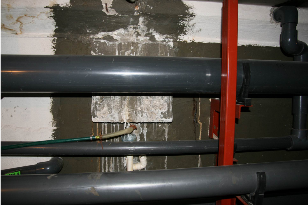
Foto 9 Podbasenie - widoczne przecieki - gniazdo lampy
