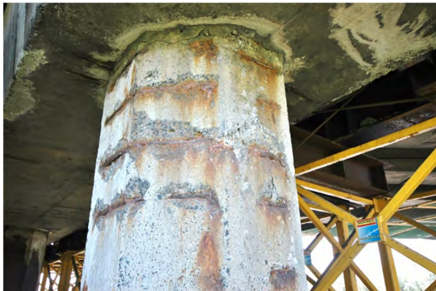
Fot.4.19 – Uszkodzenia słupa podpory 4. Ubytki otuliny, zawilgocenia i korozja stali zbrojeniowej strzemion
