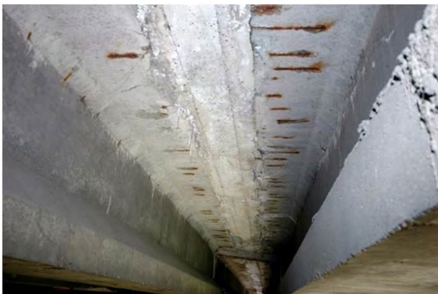
Fot.6.5 – Spód płyty pomostu na styku dźwigarów – korozja zbrojenia rozdzielczego.
