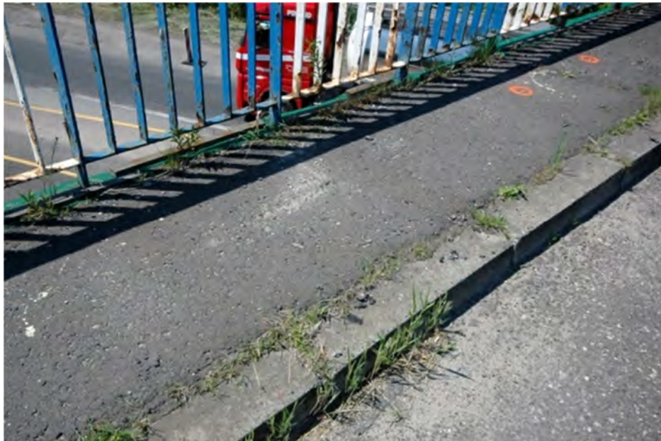
Fot.2.7 - Korozja balustrady oraz wegetacja roślinności w rejonie krawężnika i gzymsu. (Przęsło 2 – str. południowa)
