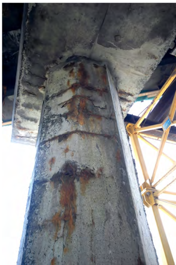
Fot.4.13 – Słup skrajny podpory 3. Korozja zbrojenia oraz złuszczenia i ubytki betonu słupa i oczepu.
