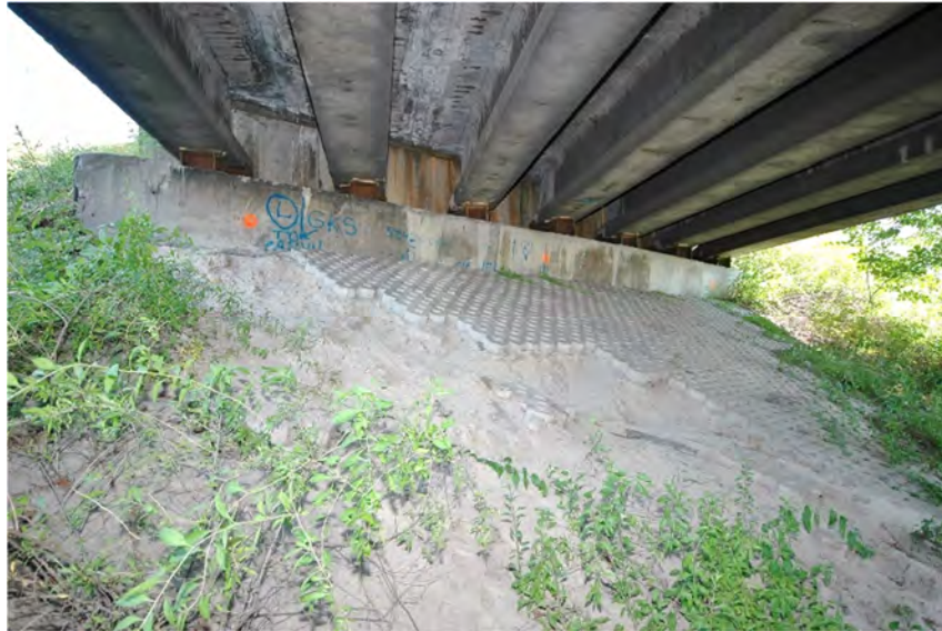
Fot 3.10 – Przyczółek (podpora 5). Braki płyt betonowych zabezpieczających skarpę pod przyczółkiem. Widoczne zacieki na stykach belek głównych oraz na ścianie zapleczej. Stożek nasypowy nieumocniony i częściowo porośnięty roślinnością. Podparcie tymczasowe belek na stołkach stalowych).
