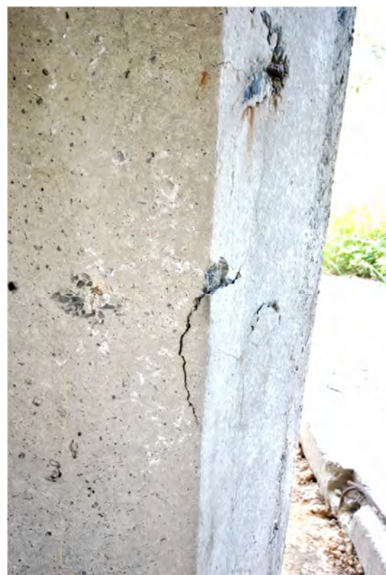
Fot.4.24 – Odspojenia otuliny betonowej słupa w narożu (podpora 4)
