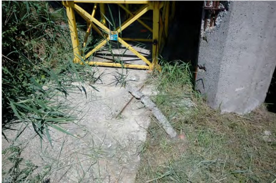
Fot.4.5 –Płyta podpory tymczasowej wraz z uszkodzoną otuliną słupa
