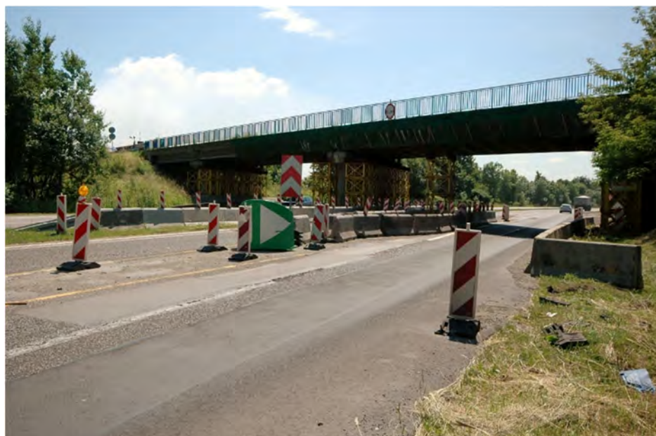
Fot.9.3 – Elementy zabezpieczenia ruchu i oznakowania tymczasowego na jezdni w kierunku Cieszyna (widok 1 w kierunku południowym z pobocza jezdni)
