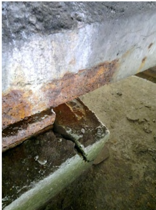
Fot.6.11 – Pęknięcie ciosu podłożyskowego.
