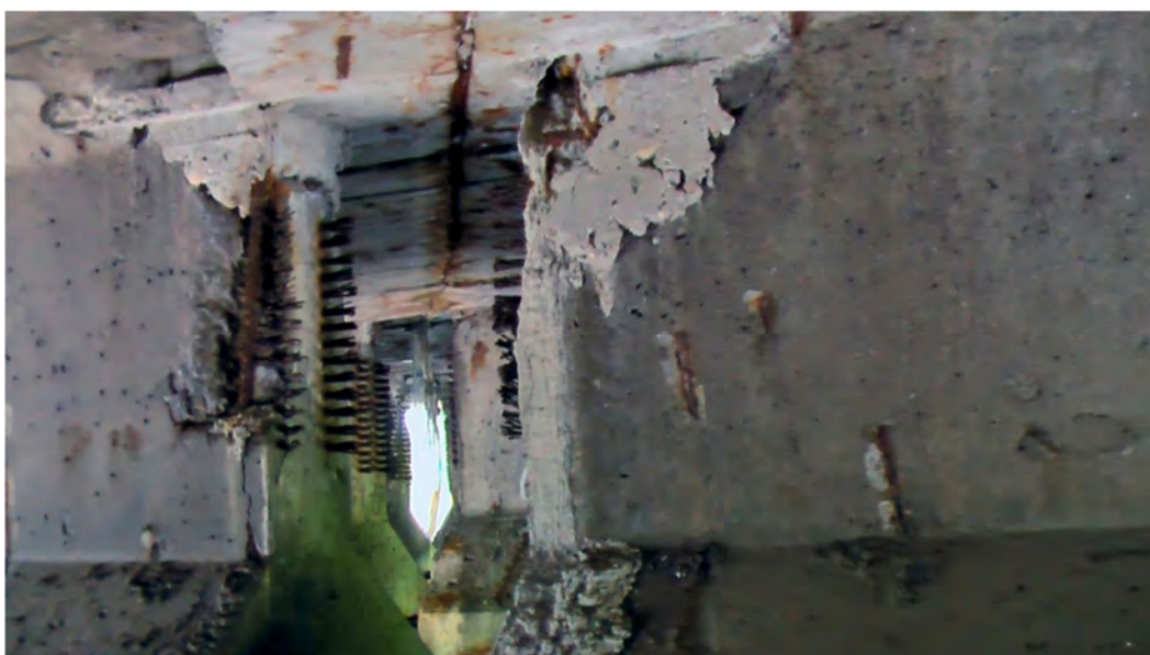
Fot.6.8 – Korozja belek w miejscu dylatacji. Widoczne zawilgocenia i wykwyty .
