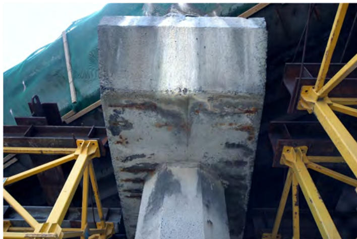
Fot.4.11 – Oczep i słup skrajny podpory 3. Widoczne skorodowane zbrojenie na skutek niedostatecznej otuliny.
