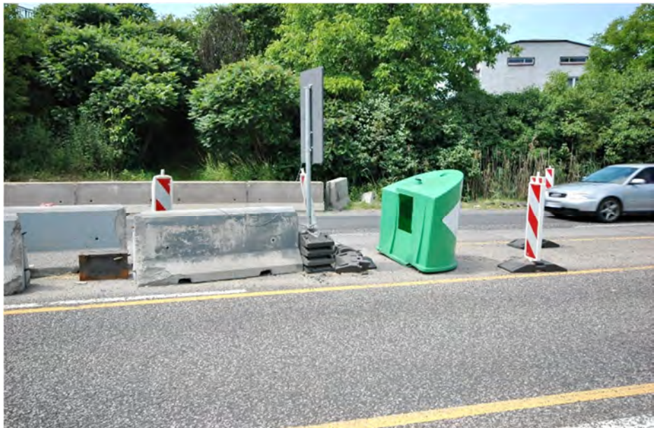
Fot.9.5 – Ośłona energochłonna na klinie rozdziału pasów ruchu wraz z barierami betonowymi i ogranicznikami skrajni – widok 2 z boku.
