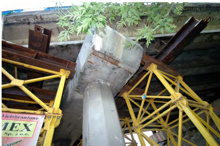
Fot.4.7 – Wieże podparcia tymczasowego przęseł 1 i 2. Odslonięte i skorodowane zbrojenie oczepu.(Podpora 2)
