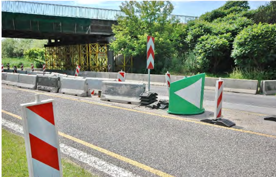
Fot.9.4 – Ośłona energochłonna na klinie rozdziału pasów ruchu wraz z barierami betonowymi i ogranicznikami skrajni – widok 1 od czoła.
