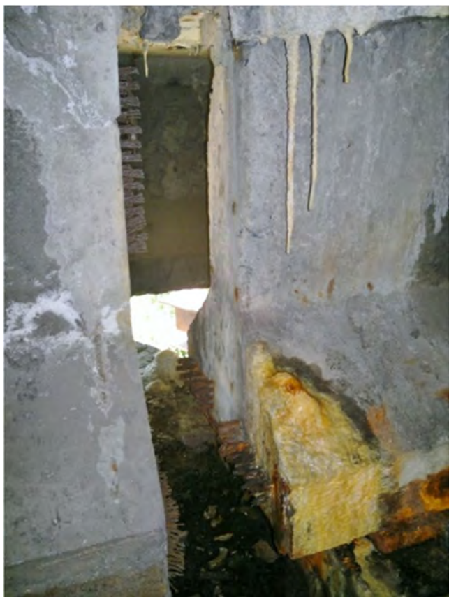
Fot.6.12 – Zawilgocenia i nawisy solne w rejonie czoła belek spowodowane przeciekami dylatacji
