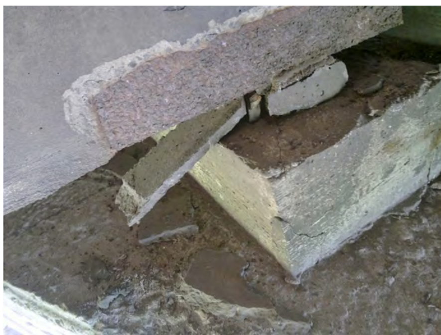
Fot.6.9 – Uszkodzenia belki w strefie podporowej nad łożyskiem. Odspojenie otuliny betonowej belki. Uszkodzenia ciosu podłożyskowego
