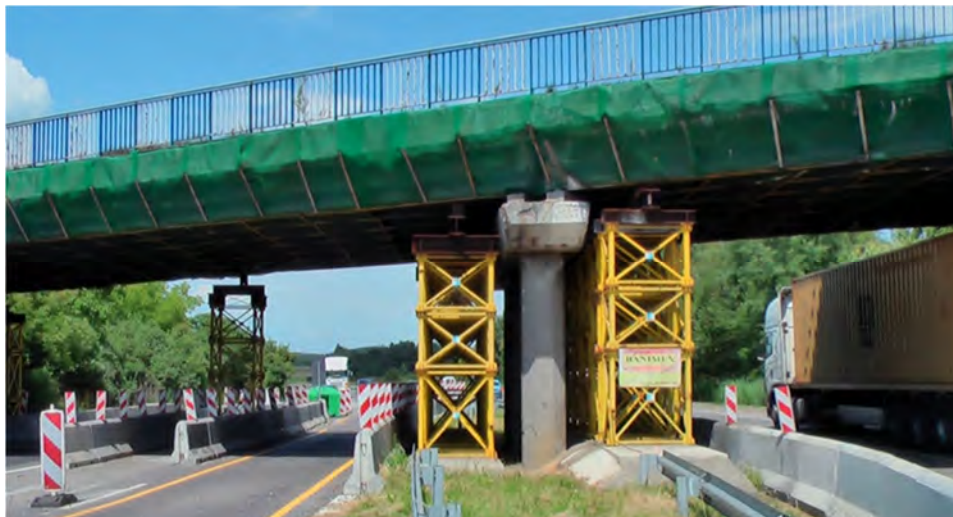
Fot.8.4 – Podparcie tymczasowe przęsła 2 i 3 w rejonie podpory 3 w pasie rozdziału jezdni (widok od strony południowej)
