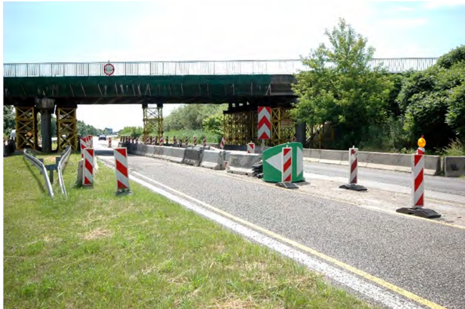
Fot.9.2 – Elementy zabezpieczenia ruchu i oznakowania tymczasowego na jezdni w kierunku Cieszyna (widok 2 w kierunku południowym z pasa rozdziału)
