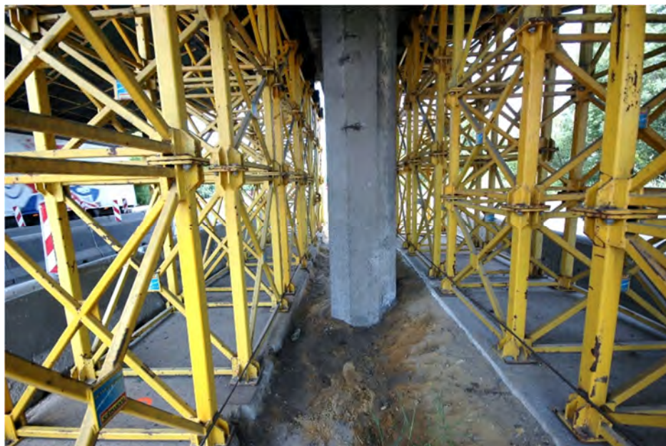
Fot.4.9 – Słup pośredni podpory 3. Widoczne uszkodzenie otuliny i odsłonięte zbrojenie.
