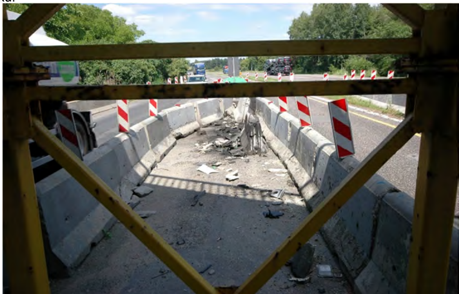
Fot.9.6 – Widok na klin rozdziału pasów ruchu od strony podpory tymczasowej podpierającej uszkodzoną belkę – podpora na jezdni w kier. Cieszyna.
