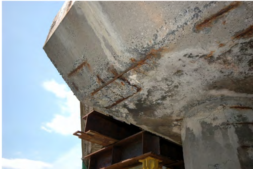
Fot.4.18 – Zawilgocenie na spodzie oczepu podpory 4. Ubytki otuliny, zawilgocenia i korozja stali zbrojeniowej.
