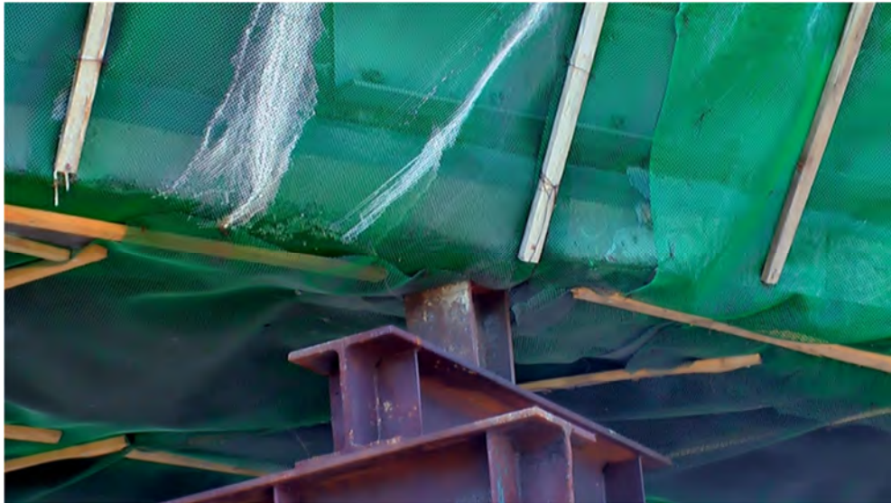
Fot.5.3 – Bezpośrednie podparcie (stół stalowy) w miejscu uszkodzenia belki skrajnej (widok od str. Siewierza)
