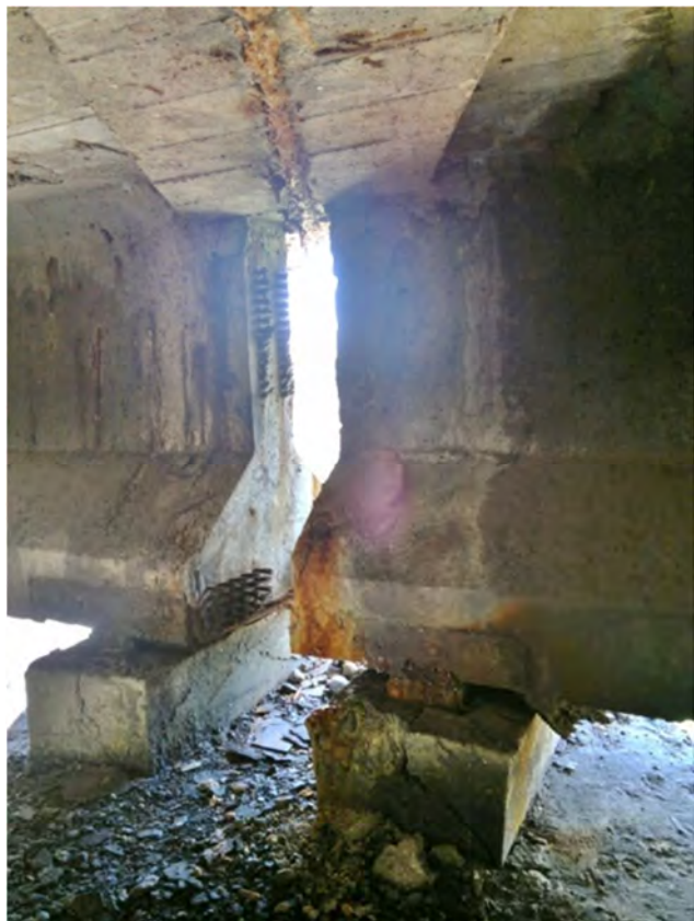
Fot.6.10 – Korozja powierzchniowa w rejonie dylatacji. Uszkodzenia – pęknięcia ciosów podłożyskowych
