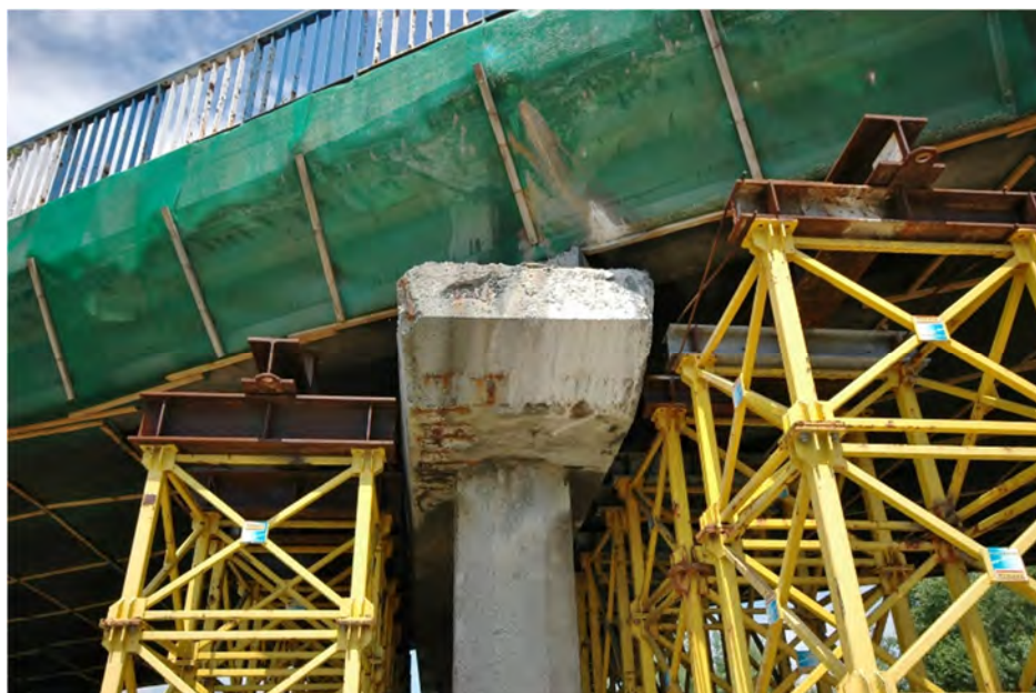
Fot.4.10 – Oczep podpory 3. Widoczne uszkodzenie otuliny, ubytki betonu oraz uszkodzenia gzymsu (pod siatką osłonową).
