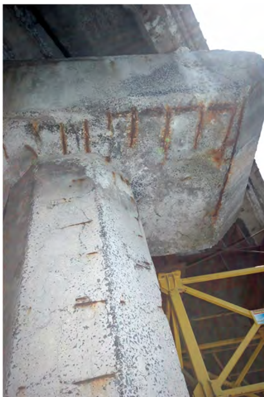
Fot.4.3 – Oczep i słup skrajny podpory 2. Widoczne skorodowane zbrojenie na skutek niedostatecznej otuliny.
