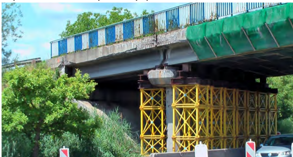
Fot.8.3 – Podparcie tymczasowe przęsła 1 i 2 w rejonie podpory 2 (widok od strony południowej)
