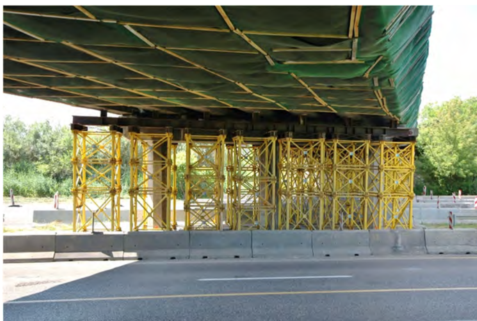
Fot.8.6 – Podparcie tymczasowe przęsła 2 i 3 w rejonie podpory 3 w pasie rozdziału jezdni (widok 2 od strony pobocza jezdni kierunku Siewierza)
