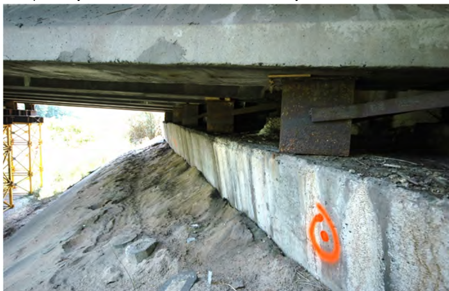
Fot.3.3 – Przyczółek (podpora 1). Widok na ławę podłożyskową i stołki podparcia tymczasowego od strony północnej.
