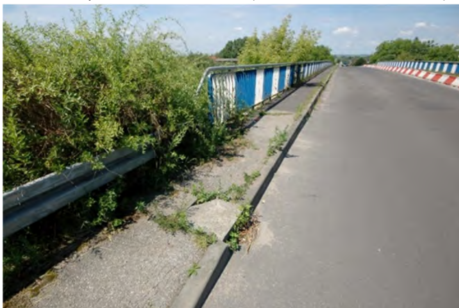
Fot.2.2 - Zdeformowany chodnik. Swobodna vegetacja roślinności. Osiadanie bariery energochłonnej. Miejsce odprowadzania wody z pomostu. (Przyczółek 5 – strona południowa)
