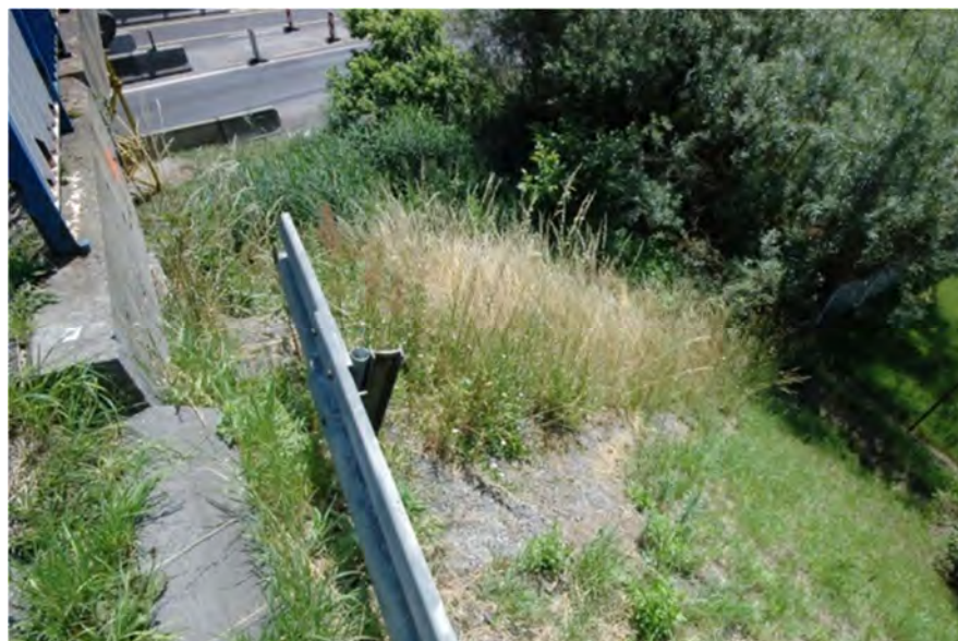
Fot.9.11 – Uszkodzona bariera drogowa na dojeździe od strony Wojkowic – bariera od strony południowej (widok 2).
