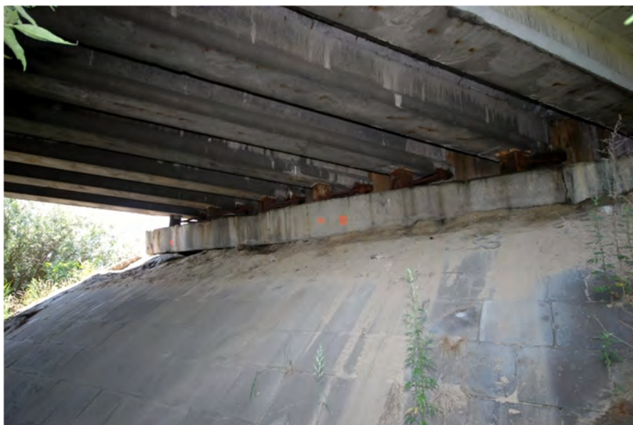
Fot.3.1 – Przyczółek (podpora 1). Widoczne zacieki na krawędzi oczepu na skutek nieszczelnej dylatacji. Braki płyt betonowych zabezpieczających skarpe pod przyczółkiem. Widoczne odsłonięte skorodowane zbrojenie. Podparcie tymczasowe belek na stołkach stalowych.
