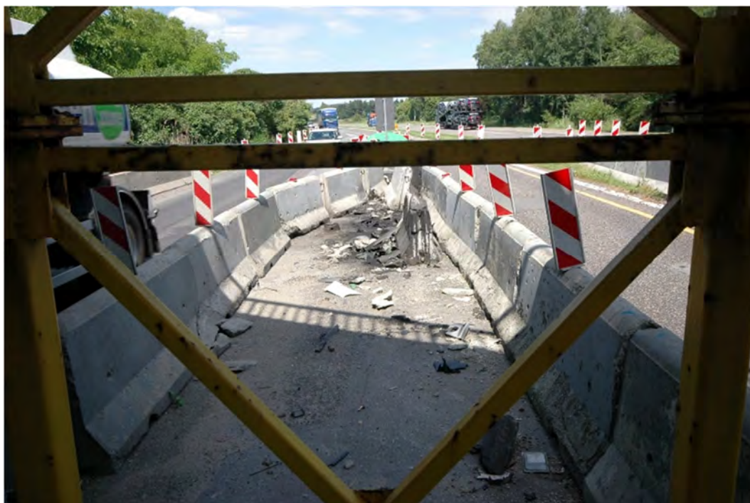
Fot.5.2 – Zabezpieczenie podparcia tymczasowego uszkodzonej belki barierami betonowymi od strony Siewierza na jezdni w kier. Cieszyna.
