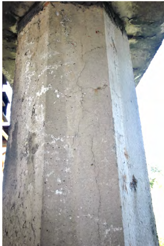
Fot.4.22 – Rysy w górnej części słupa podpory 4, widoczne wykwyty na oczepie.
