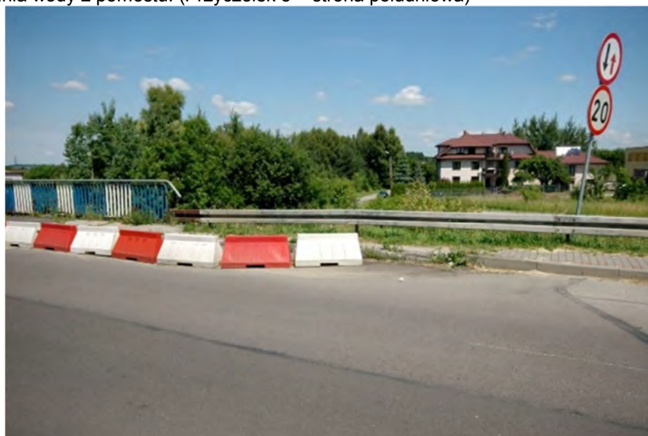
Fot.2.3 - Zdeformowany chodnik. Swobodna vegetacja roślinności. Deformacja oznakowania pionowego. Początek zabezpieczenia z barier tworzywowych. (Przyczółek 5 – strona północna)
