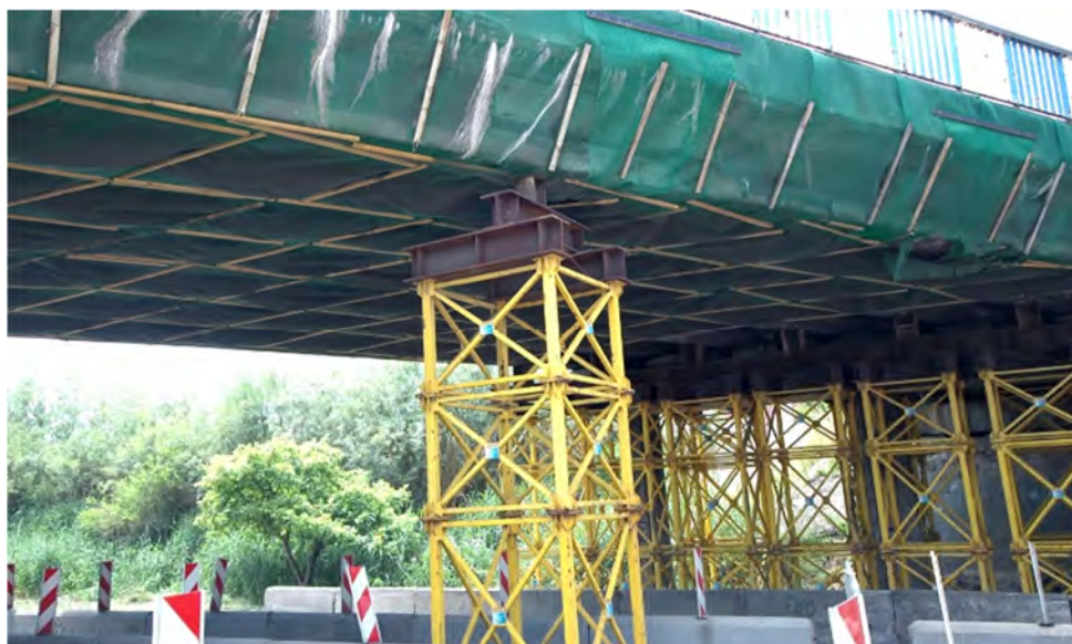
Fot.8.2 – Podparcie tymczasowe uszkodzonej belki skrajnej
