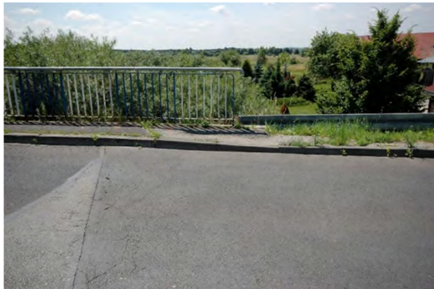
Fot.9.10 – Uszkodzona bariera drogowa na styku nasypu drogowego i obiektu przy przyczółku nr 1 od strony Wojkowic – bariera od strony południowej (widok 1).
