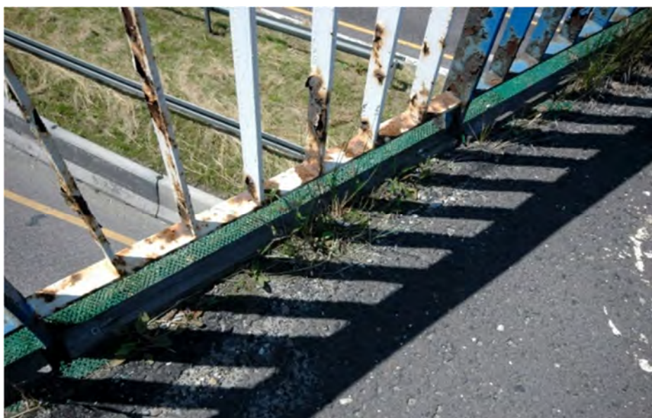
Fot.2.6 - Korozja balustrady oraz wegetacja roślinności w rejonie gzymsu. (Przęsło 3 – strona południowa)
