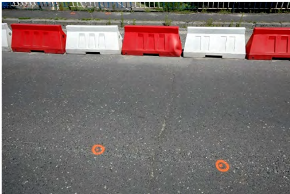
Fot.2.8 - Pęknięcia podłużne i poprzeczne nawierzchni w rejonie dylatacji przęseł 2 i 3. Lokalizacja reperów
