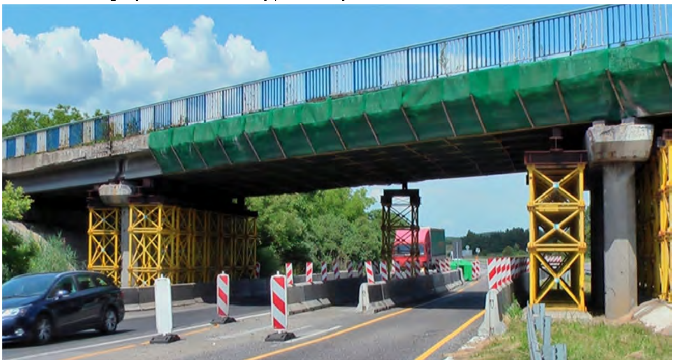
Fot.1.2 - Tymczasowe podparcie na kłatkach rusztowaniowych w przęśle 2.
