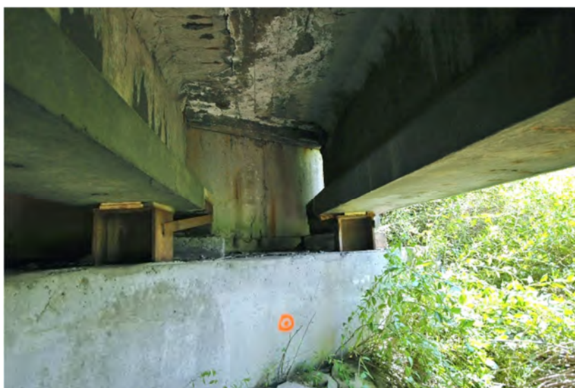
Fot 3.15 – Podparcie belek od strony południowej, podklinowanie na stołkach montażowych. Zawilgocenia i wykwyty na styku belek oraz na środnikach belek. Przyczółek (podpora 5).
