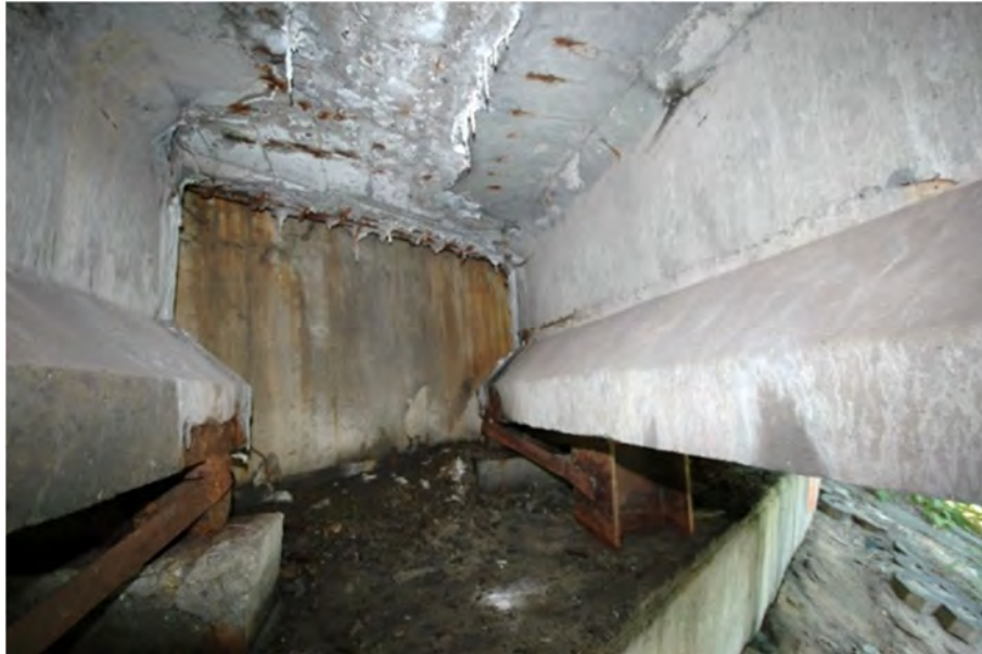
Fot 3.7 – Zawilgocenie ławy podłożyskowej i ścianki zapleczej, nieszczelności izolacji na styku belek, widoczne odsłonięte skorodowane zbrojenie i korozja elementów podpierających. (Podpora 1).
