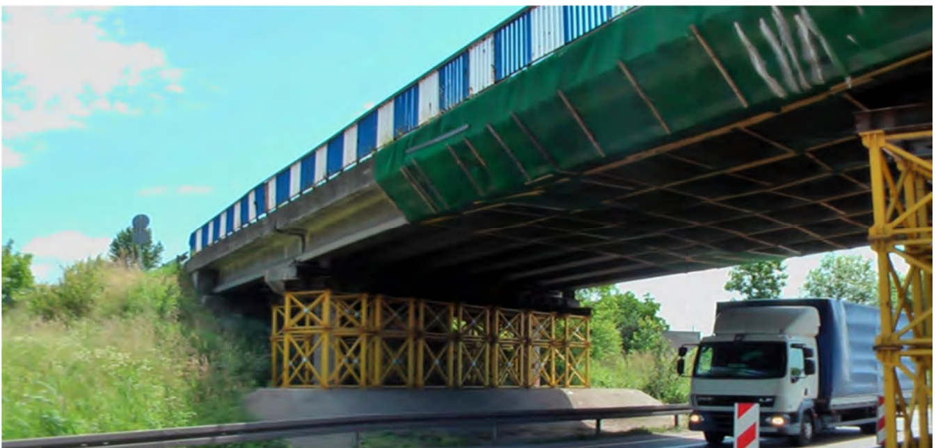
Fot.1.3 - Tymczasowe podparcie na kłatkach rusztowaniowych i zabezpiecz. spodu konstr. w przęśle 3
