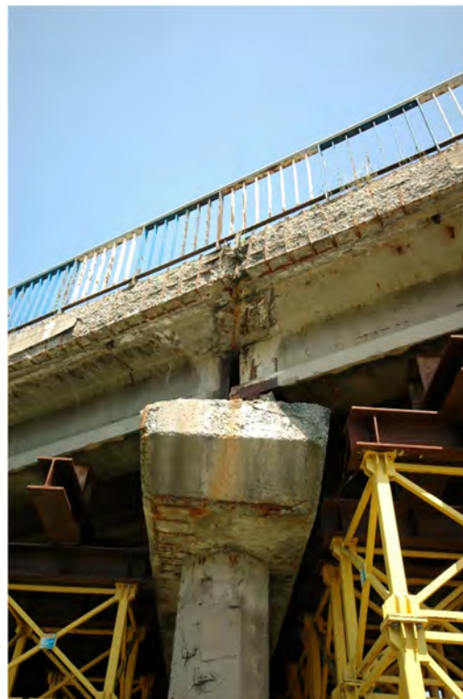
Fot.4.2 – Odspojony beton, widoczne odłonięte skorodowane zbrojenie gzymsu oraz na słupie podpory 2.
