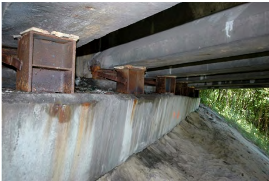
Fot 3.8 – Zawilgocenie oczepu wieńczącego przyczółek, zacieki na ścianie pionowej, korozja elementów podpierających. Widoczne podklinowanie konstrukcji na stołkach podpierających. (Podpora 1).
