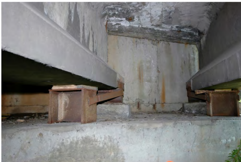
Fot 3.16 – Podparcie belek od strony południowej, podklinowanie na stołkach montażowych. wykwyty na styku belek złączenia betonu na środnikach belek Rdzawe naloty na ścianie zapleczonej. Przyczółek (podpora 5).
