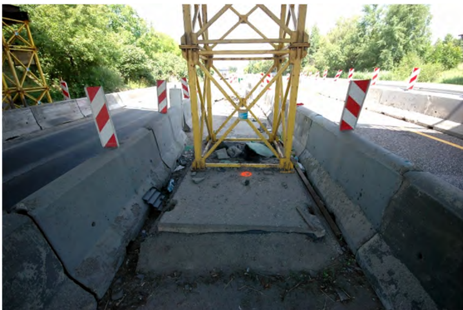
Fot.5.5 – Podpora klatki podpierającej uszkodzoną belkę.
