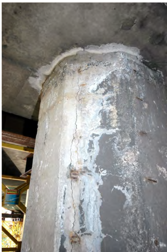
Fot.4.23 – Rysy w górnej części słupa podpory 4, widoczne wykwyty na oczepie.
