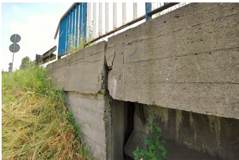
Fot 3.14 – Przyczółek (podpora 5). Uszkodzenie gzymsu w rejonie dylatacji. Widok od strony północnej.
