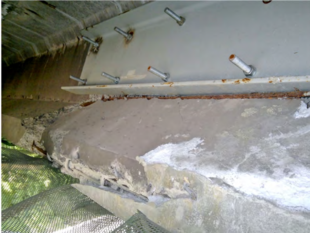
Fot.7.4 – Fragment pasa dolnego dźwigara poniżej miejsca usztywnienia nakładkami – widok 2
