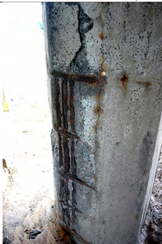
Fot.4.12 – Słup skrajny podpory 3. Widoczna bardzo duża korozja zbrojenia oraz znaczne ubytki betonu.
