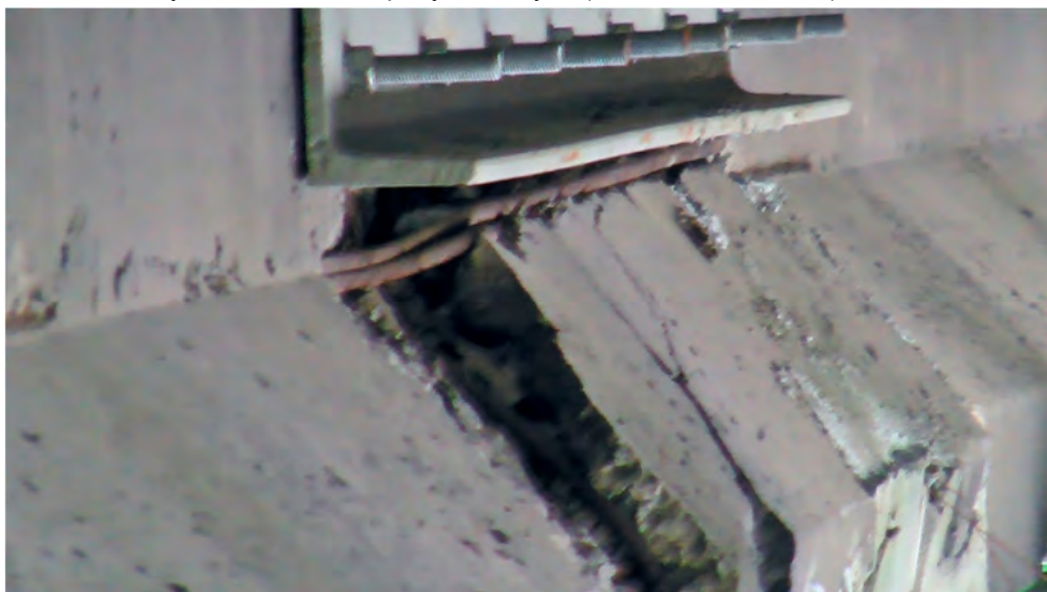
Fot.7.3 – Fragment pasa dolnego dźwigara poniżej miejsca usztywnienia nakładkami – widok 1
