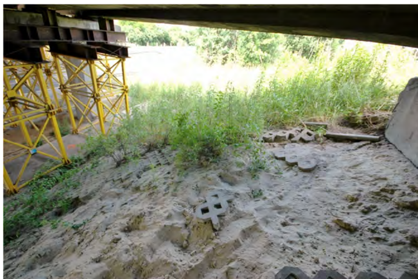
Fot 3.12 – Przyczółek (podpora 5). Braki w umocnieniu stożka nasypowego.
