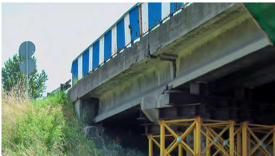
Fot.8.8 – Podparcie tymczasowe przęśła 3 i 4 w rejonie podpory 4 (widok 2 od strony północnej)
