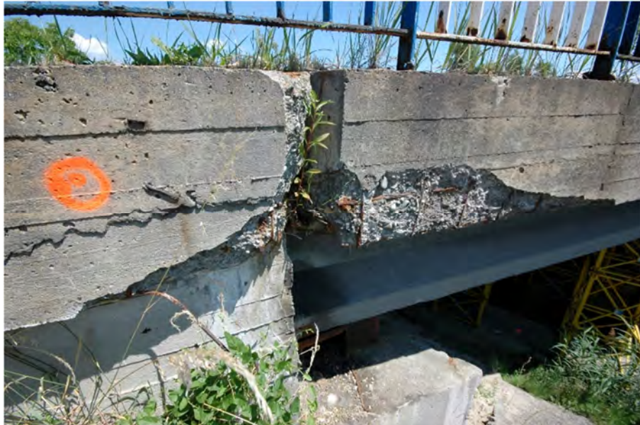
Fot.3.4 – Uszkodzenie gzymsu, widoczne odsłonięte zbrojenie na przyczółku (podpora 1).
