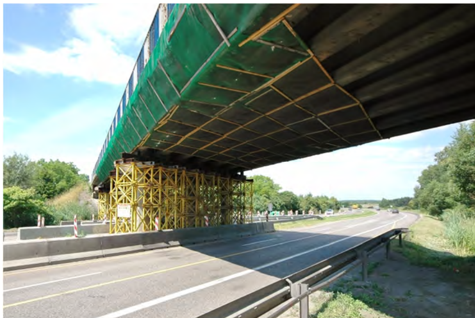
Fot.8.5 – Podparcie tymczasowe przęsła 2 i 3 w rejonie podpory 3 w pasie rozdziału jezdni (widok 1 od strony pobocza jezdni w kierunku Siewierza)
