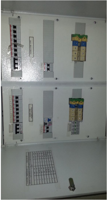
Widok istniejącej tablicy 0,4kV-TK3 którą należy przebudować
