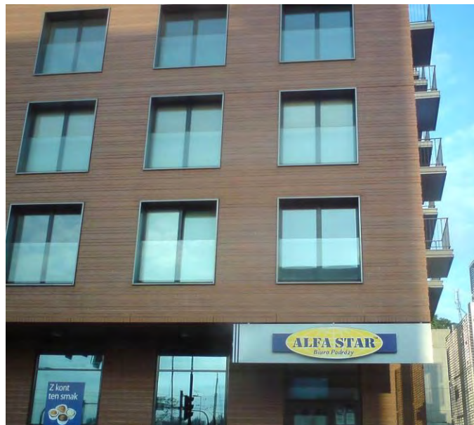
Rysunek 12-11 Ochrona mieszkań przed hałasem, za pomocą przezroczystych „ekranów” umieszczonych we wnęce okiennej (Kraków) (źródło: materiały własne).
