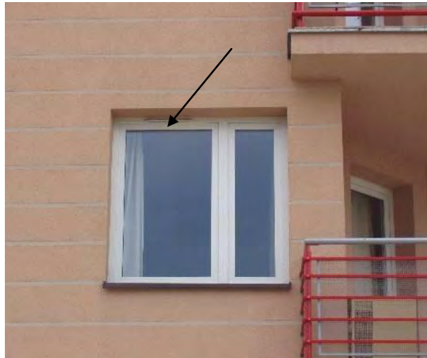
Rysunek 12-26 Okno dźwiękoszczelne z nawietrzakiem (źródło: materiały własne).
