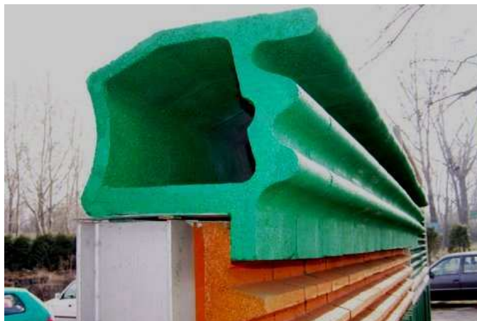
Rysunek 12-7 Dyfraktor zamontowany na krawędzi górnej ekranu akustycznego (źródło: www.techbud.com.pl )
