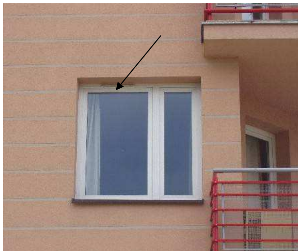
Rysunek 12-26 Okno dźwiękoszczelne z nawietrzakiem (źródło: materiały własne).
