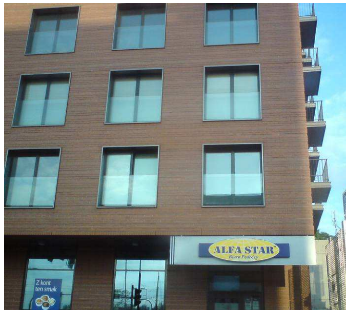
Rysunek 12-11 Ochrona mieszkań przed hałasem, za pomocą przeźroczystych „ekranów” umieszczonych we wnęce okiennej (Kraków) (źródło: materiały własne).
