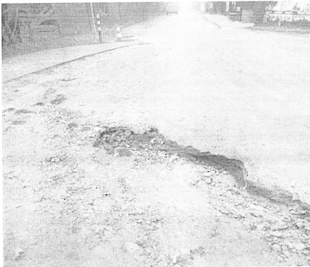
Zdjęcie 1. Ubytek nawierzchni miejsca, w którym zawracają pojazdy na końcu ul. Ratanice, stan na dzień 05.12.2024 r..
