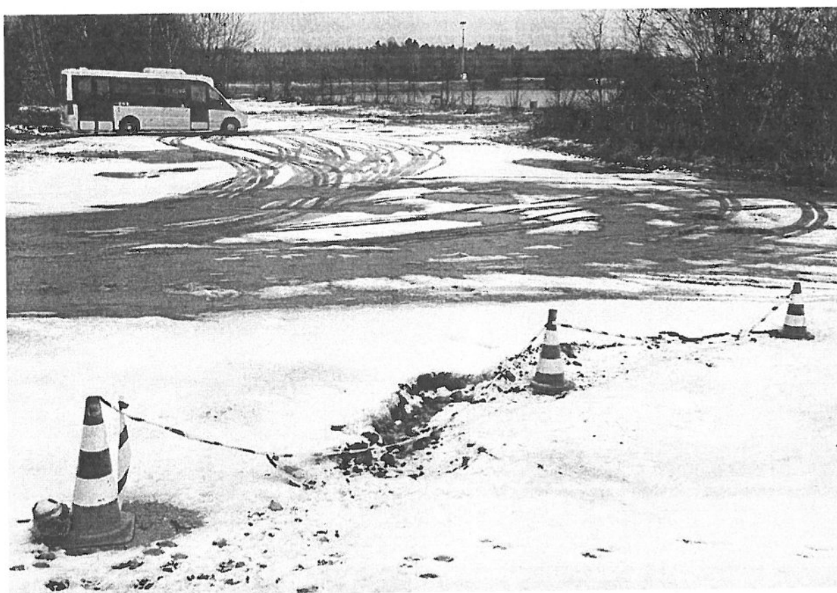
Zdjęcie 2. Zabezpieczony ubytek w nawierzchni, stan na dzień 15.12.2024 r.
