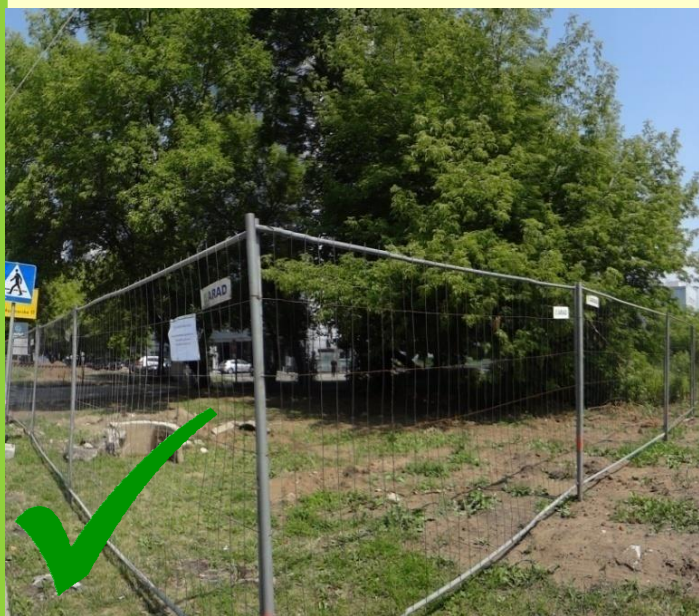
Wykonywać ogrodzenia Strefy Ochronnej Drzew.
