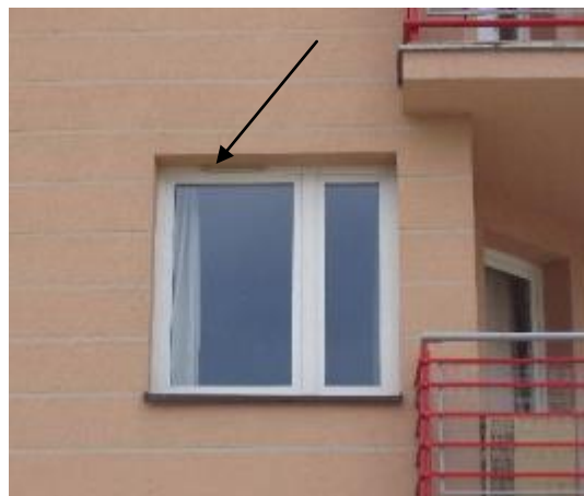
Rysunek 24. Okno dźwiękoszczelne z nawietrzakiem.
