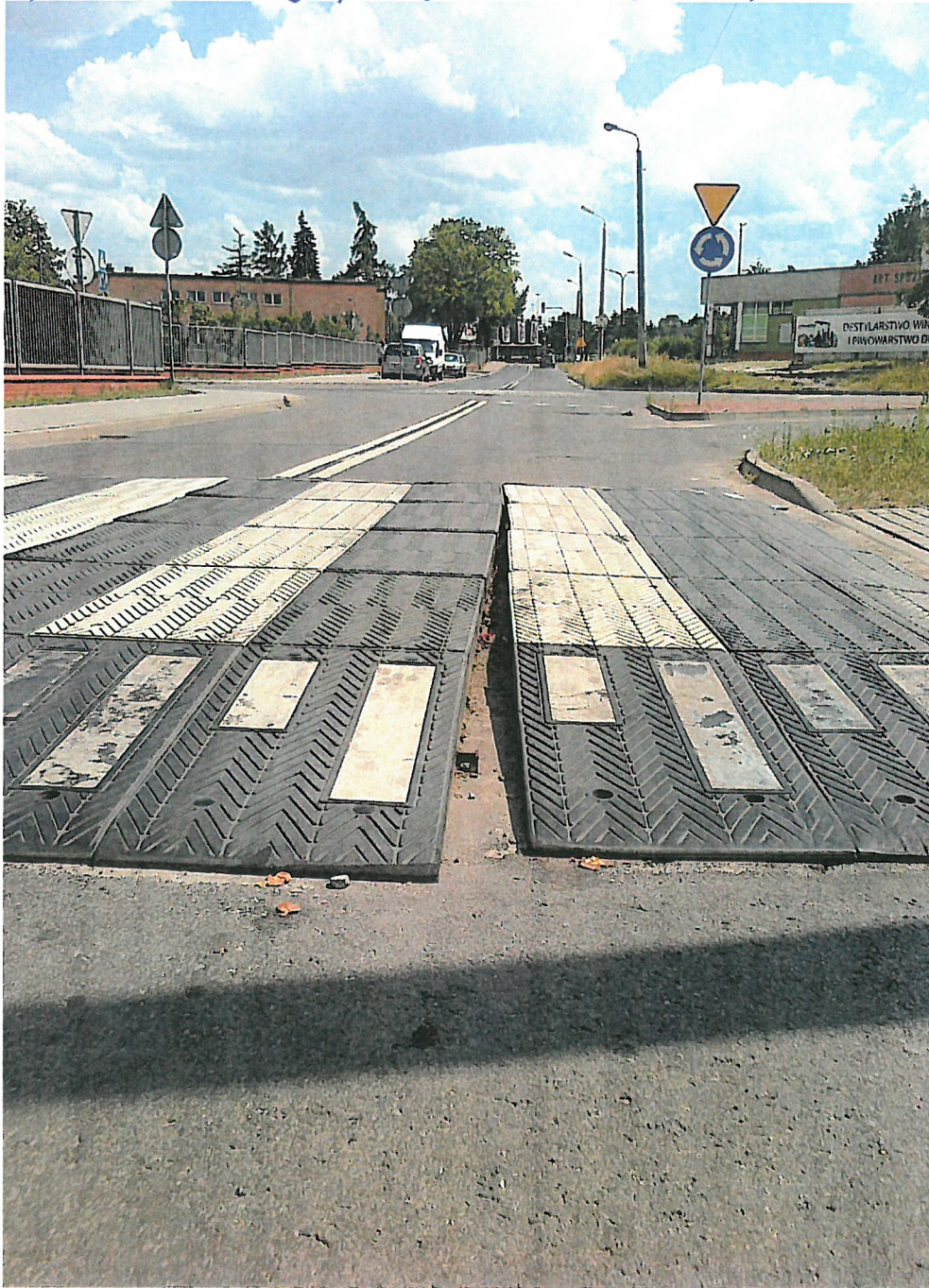
1) Uszkodzony próg zwalniający przy ul. Swobodnej
