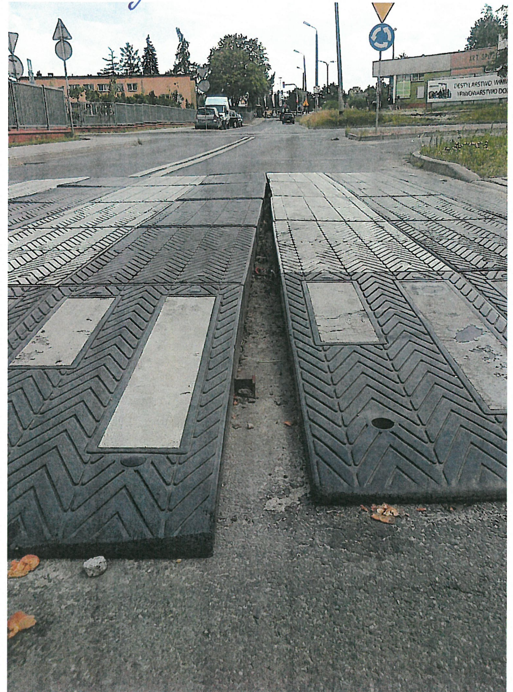
1) Uszkodzony próg zwalniający przy ul. Swobodnej
