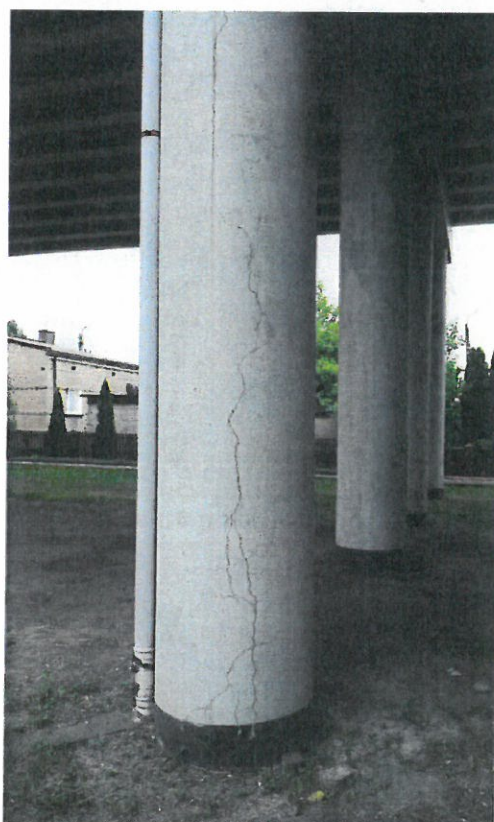
Rys. 4 Widok na filar słupowy. Widoczne liczne zarysowania i spękania słupa.
