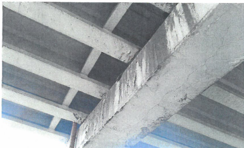
Rys. 3 Widok na podporę pośrednią. Widoczne zarysowania i spękania oczepu podpory, ubytki betonu, zacieki.
